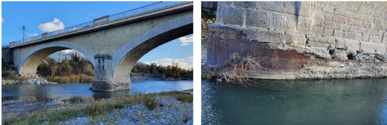
Figure 3. Vue PA et protection appui dégradée / Béton érodé (12/2022) (source : CD04)
