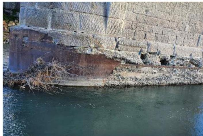
Pont d'oraison et protection appui dégradée / Béton érodé (2022)
