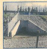
Des écoducs ou passages à petite et moyenne faune seront réalisés par le placement de tuyaux dans les remblais des infrastructures sous forme de petits tunnels. Les conditions de réalisation maîtrisées assurent à leur fonctionnalité au sein d'un environnement de passages à grande échelle et leur répartition régulière.
