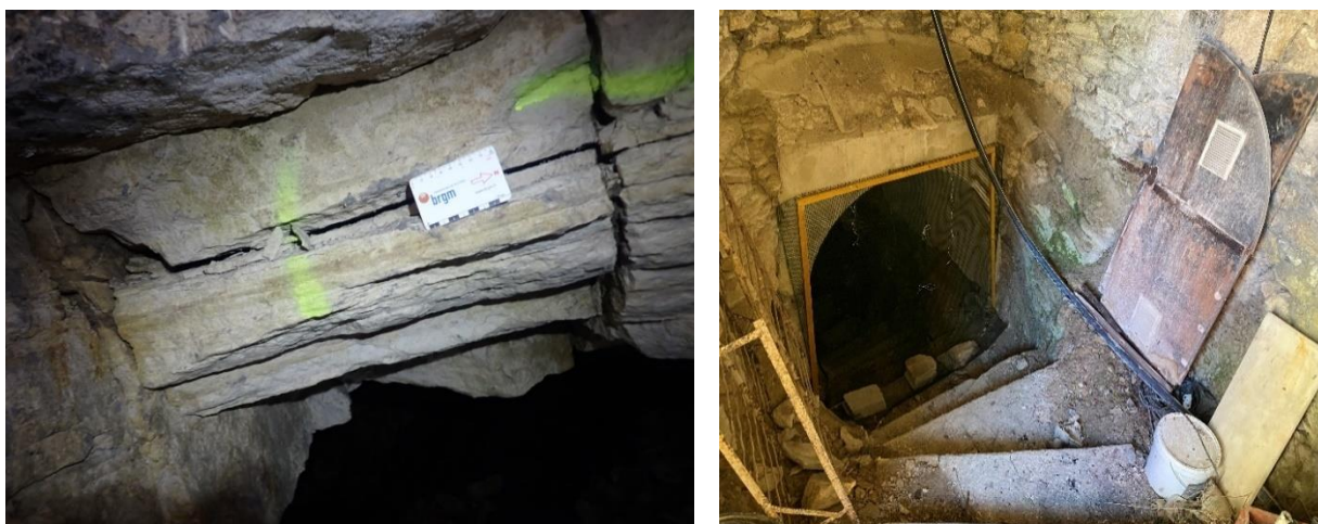
Illustration 35 : Visite de surveillance de la descenderie en septembre 2024 et sécurisation de l'entrée en novembre 2024 – Photo a : suivi de la fracturation ; photo b : fermeture de l'entrée de la descenderie – Ventabren (13).
