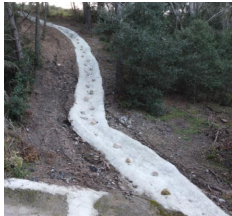
Illustration 16 : Vue drone des travaux réalisés (photo de gauche) et marques d'érosion longeant le nouveau caniveau provenant du parc photovoltaïque sur le terail du Défens – Commune de Meyreuil (13) – 12/12/2024.
