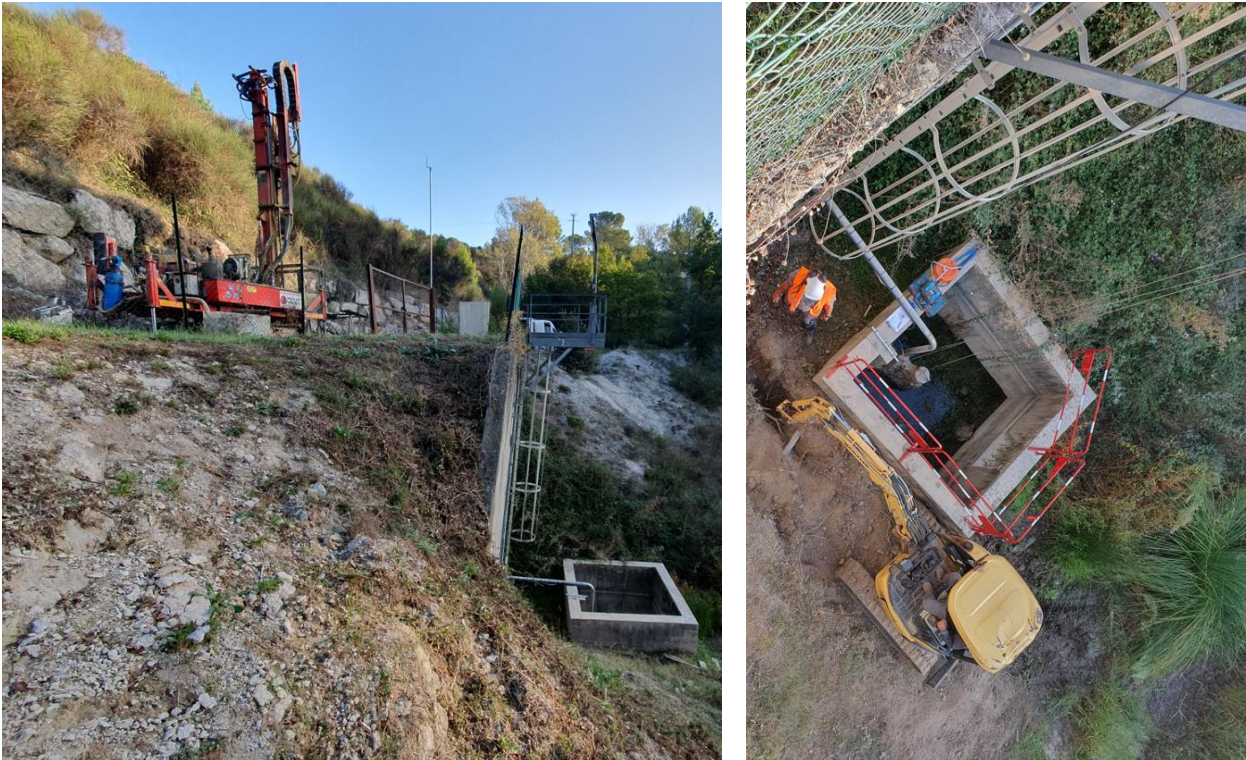
Illustration 20 : Investigations géotechniques autour du mur de soutènement du terril des Sauvaires : sondage pressiométrique en amont du mur (gauche) et puits de reconnaissance en pied de mur à l'aval (droite) – Gardanne (13).
