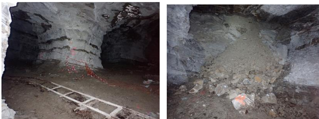
Illustration 31 : Pilier en bon état (photo de gauche), secteur effondré avec écoulement argileux (photo de droite) – Marseille (13).
