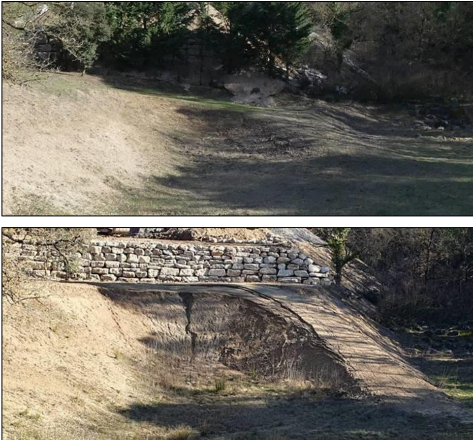
Illustration 15 : Rampe d'accès au bassin avant (photo du haut, 23/03/2023) et après (13/03/2024) travaux à l'amiable – terriil des Sauvaires (Gardanne – 13).
