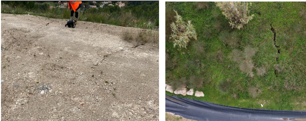
Illustration 19 : Fissures métriques sur la zone remodelée en 2023 sous le caniveau 4 (photo de gauche) et plurimétriques au-dessus du caniveau 5 (photo aérienne, côté droit) sur le talus du terri du Grapon – Commune de Meyreuil (13) – 21/11/2024.
