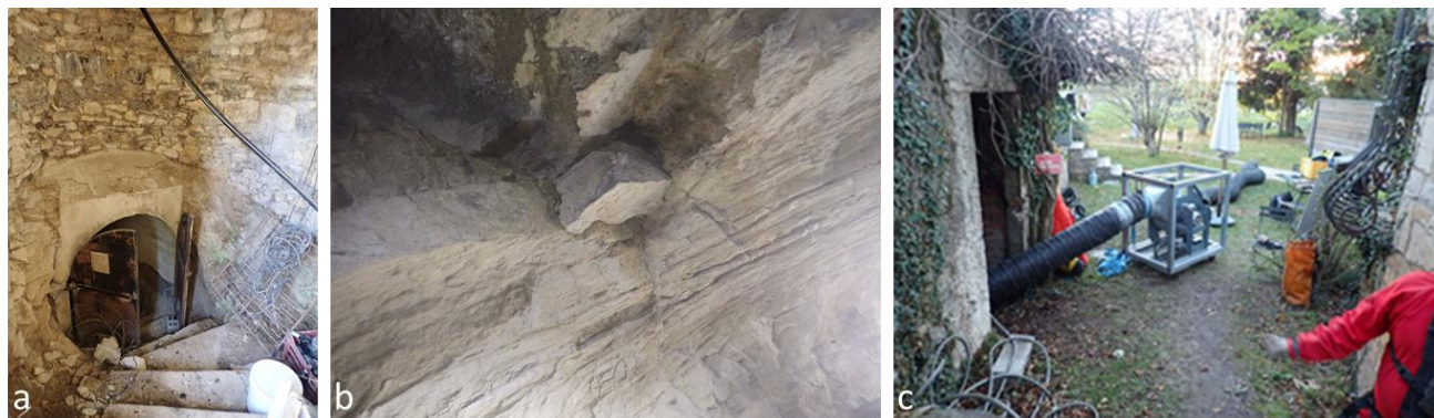
Illustration 34 : a : Entrée de la descenderie, b : décrochement de bloc au toit et dans le parement, c : système de ventilation mis en place pour éliminer le risque d'asphyxie – Ventabren (13).
