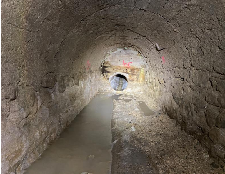
Illustration 12 : Visite de la galerie d'Audibert vue depuis l'aval – vue sur la sortie de la canalisation curée jusqu'à 42 m – terril de Mme d'André – Fuveau (13) (19/12/2024).
