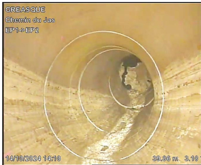
Illustration 11 : Extrait de l'inspection caméra de la canalisation – vue sur le bouchon de calcite partiellement percé sur sa partie gauche.
