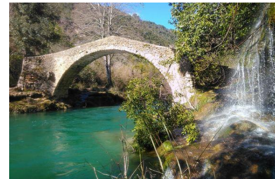
Siagne – Pont des Tuves - © Département 06
