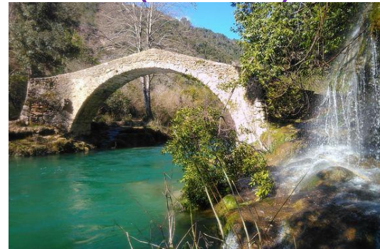
Siagne – Pont des Tuves - © Département 06
