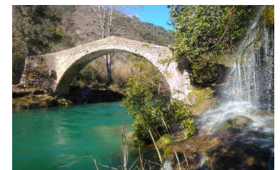
Siagne – Pont des Tuves - © Département 06
