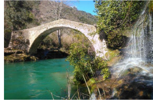
Siagne – Pont des Tuves - © Département 06
