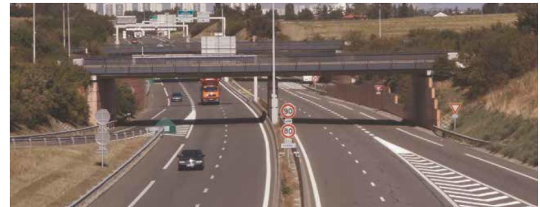
Route à 2x2 voies
