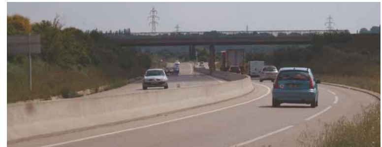
Route à 2x1 voie
