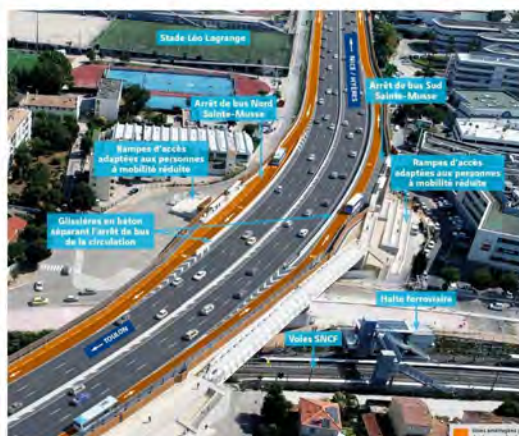
Figure : Halte autoroutière et ferroviaire de Toulon-Ste Musse (A57). Crédit : VINCI Autoroutes
