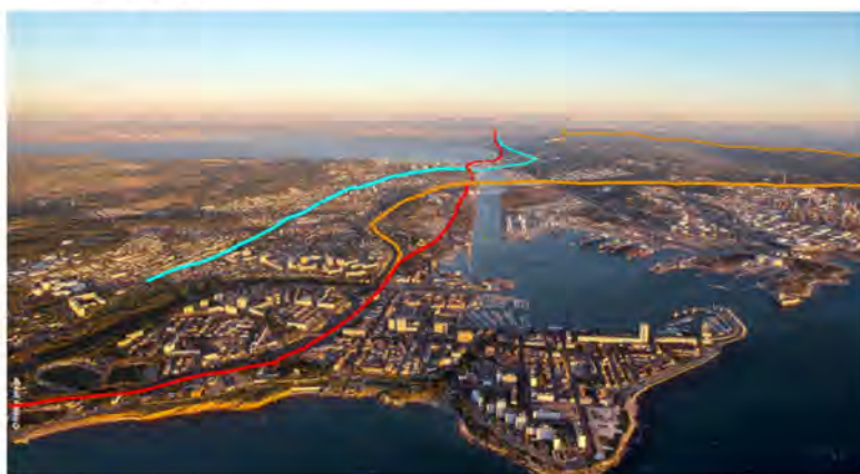
Photographie 1 : franchissement du chenal de Caronte et desserte en RER de Martigues/Port de Bouc
