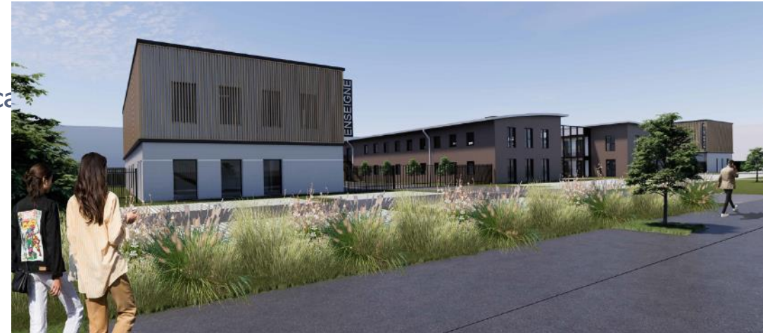
Réhabilitation de bureaux et création de locaux d'activités – SCI Balbuzard
