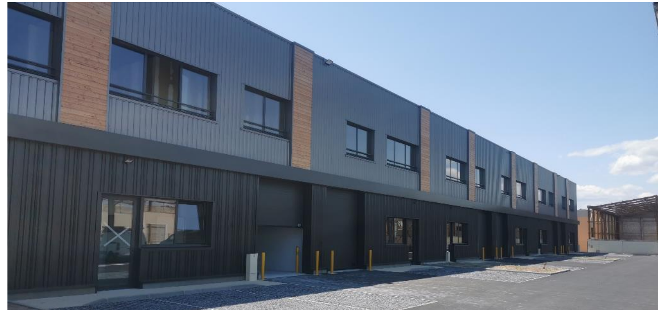
Site Bordet – Construction de locaux d'activités - GSE
