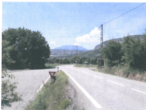
Vue rapprochée du carrefour depuis la RD 900 B
