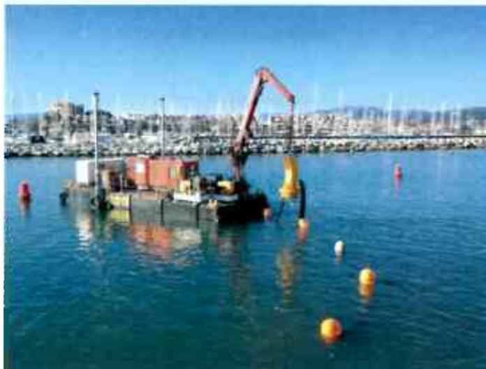
Figure 11 : Atelier de dragage hydraulique opérant à Port Grimaud 1
