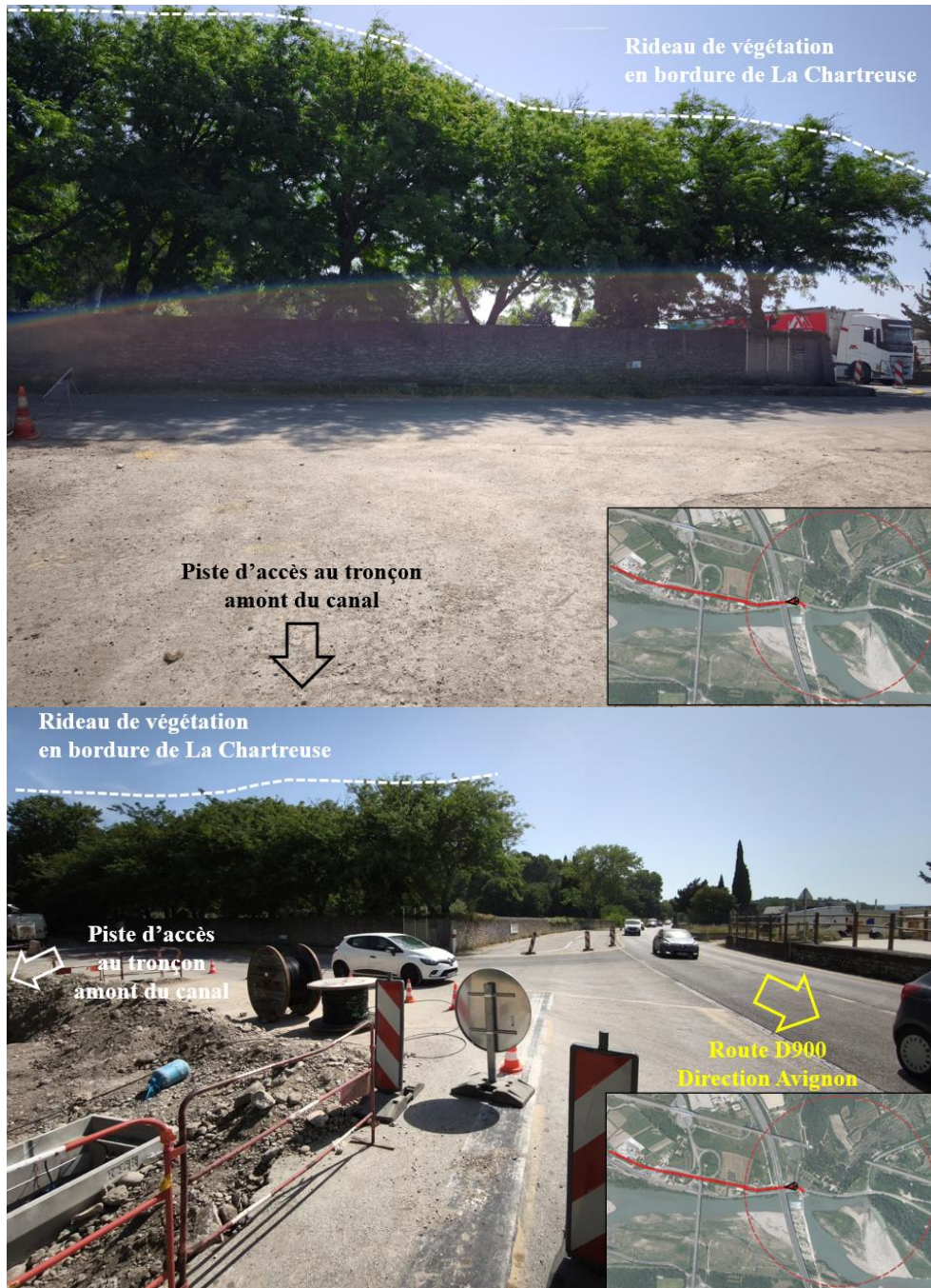
Figure 6 : Prise de vue en direction du site classé depuis la piste du chantier (Google Earth)
