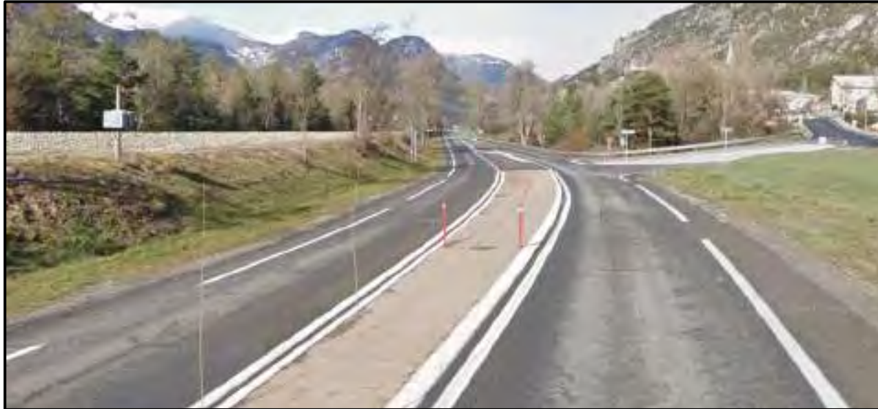
Tourne-à-gauche et îlot central surélevé (Saint-Crépin)
