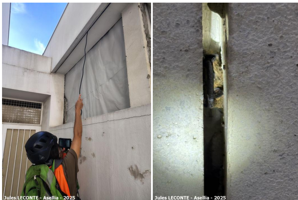
Photo 1 : Inspection des interstices à l'aide d'un endoscope (gauche), individu de pipistrellus sp. contacté sur le bâtiment n°1 (droite)
