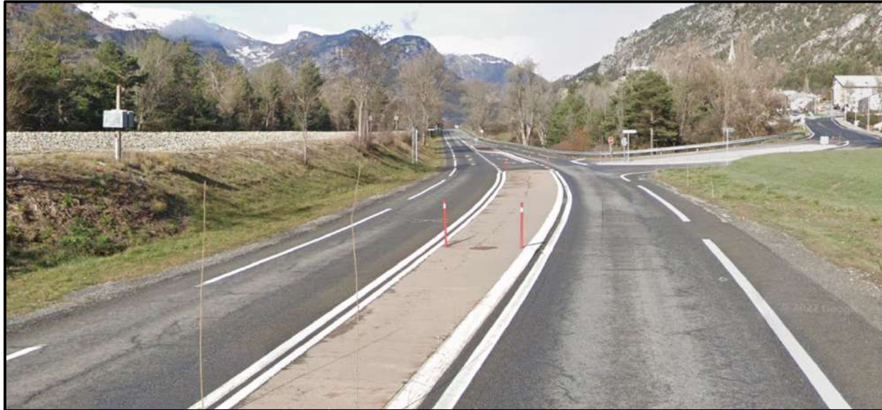
Tourne-à-gauche et îlot central surélevé (Saint-Crépin)
