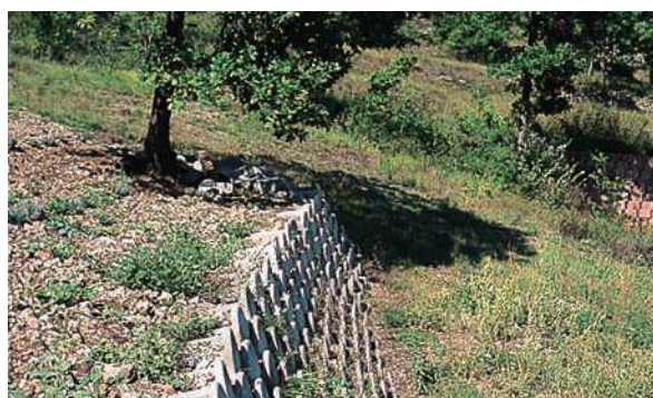
L'écomusée du Pays de la Roudoule a participé, dans le cadre d'un programme européen, à des travaux permettant la préservation ou la réhabilitation des terrasses de culture.
