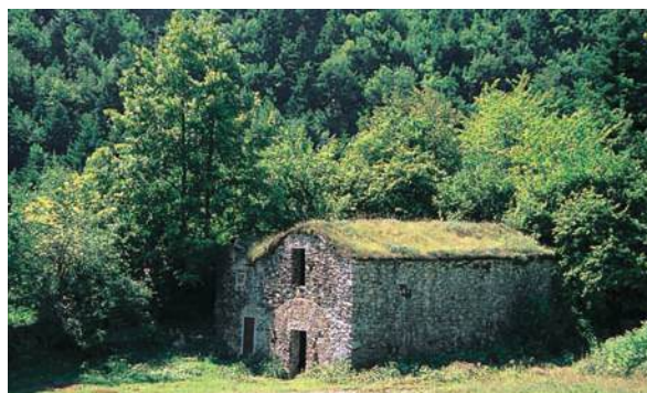
Les silhouettes des villages perchés et les caractéristiques architecturales (comme les toitures voûtées) marquent fortement l'identité paysagère de la vallée.
