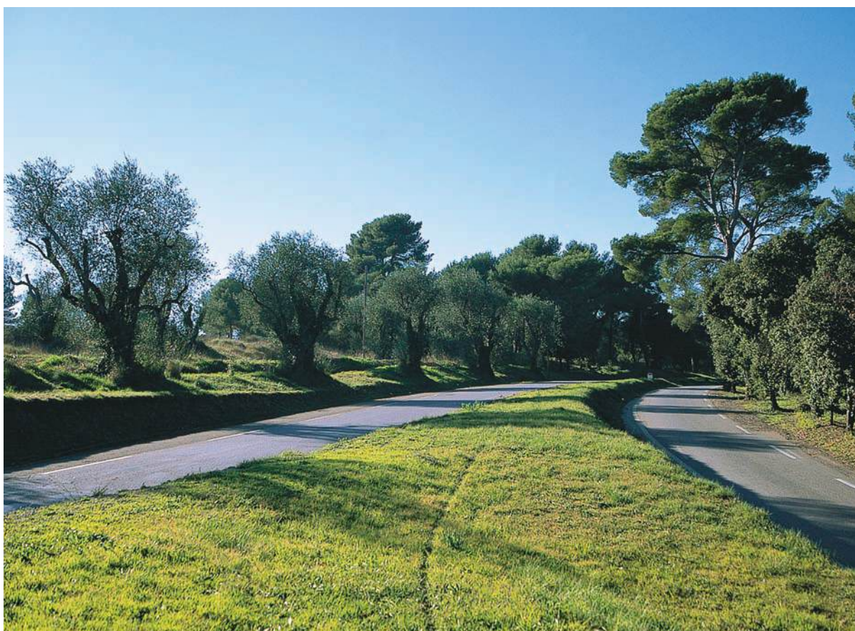
Route départementale 504 à Sophia (route réalisée sur le modèle de l'ingénieur Prost, ingénieur routier du XX e siècle).
