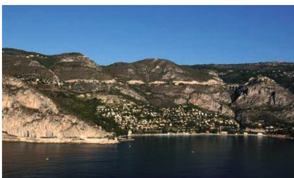
L'urbanisation concentrée en bas de pente entre les caps s'élève aussi sur le versant à proximité des voies en corniche : l'impact visuel est important d'autant plus que les constructions s'imposent au relief.
