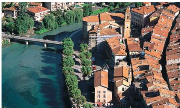
La Roya est un milieu riche, dont la présence domine l'ambiance de la vallée et en structure le système.
