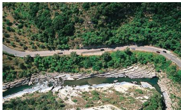
Dans cette vallée étroite, la route suit le lit du fleuve. Le cours d'eau et ses berges sont ainsi très sensibles à toute intervention sur cette voie, axe traditionnel de liaison entre le Piémont et la Méditerranée.
