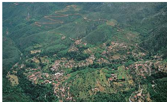
Impact visuel fort des constructions mal adaptées à la pente ou concurrençant le relief. Le mitage des versants brouille la perception des silhouettes des villages.
