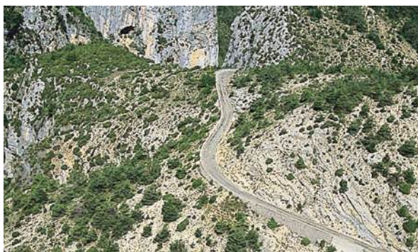
De très belles routes sont bâties en balcon, avec un soutènement et un parapet de pierre.
