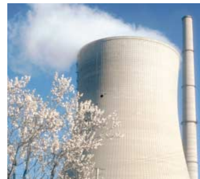
Centrale thermique SETCM - Gardanne - [Photo: R. Bourguet]
