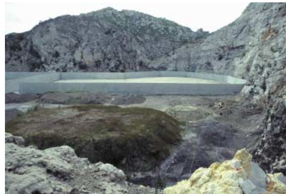
Ancien site industriel de l'Estaque (Marseille) : Futur stockage destiné au confinement commun des déchets d'Atofina et de Metaleurop (résidus de pyrites notamment).
