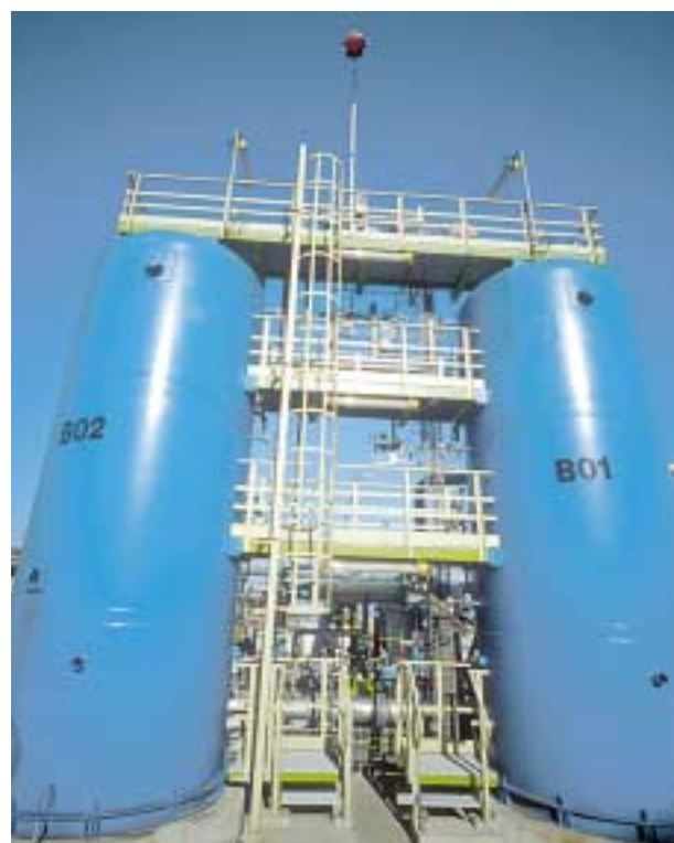
Unité de récupération de vapeurs à la Raffinerie de Provence (Groupe Totalinaelf) [Photo : R. Mas]
