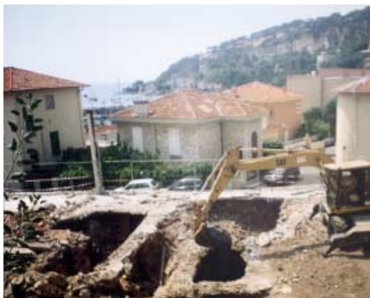
Chantier de dépollution de l'ancienne usine à gaz de Villefranche-sur-Mer (1 er trimestre 2001). Maître d'ouvrage Gaz de France – Maître d'œuvre ERG
