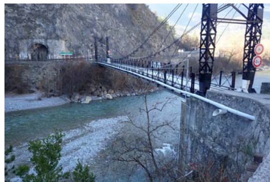
Station de Malaussène sur le fleuve VAR (06) (Source : DREAL PACA)
