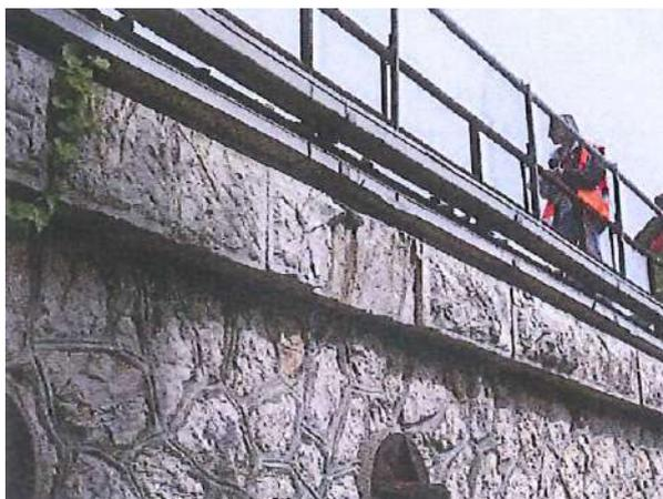
De plus, les tympans présentent quelques moellons altérés en surface et surtout de nombreux joints creux. Ces pathologies sont présentes, en particulier, sur une hauteur d'un mètre sous les pierres de plinthe.
