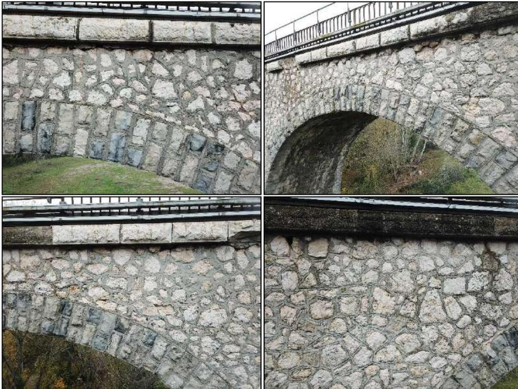
Figure 26 : Photographies de cavités sur le viaduc par le drone (Source : Géo+ Environnement)
