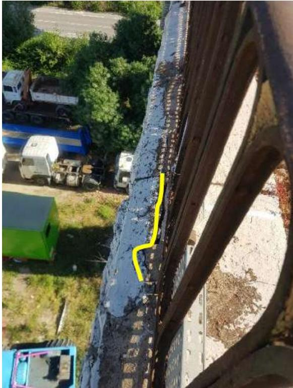
Fissuration longitudinale de la plinthe côté droit
