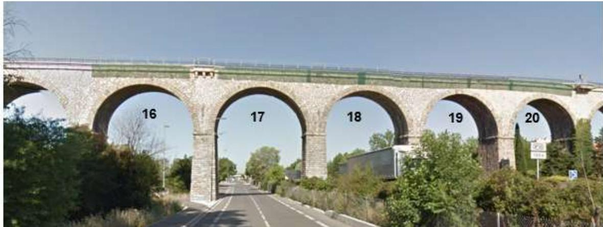
À la suite de l'incident de chute de pierres depuis le viaduc constaté le 03 juin 2021, les filets de protection ont été remplacés le 14/10/2021 et des nouveaux filets ont été installés à Gauche et Droite des arches 2 à 8 – 16 à 20 et 37.
