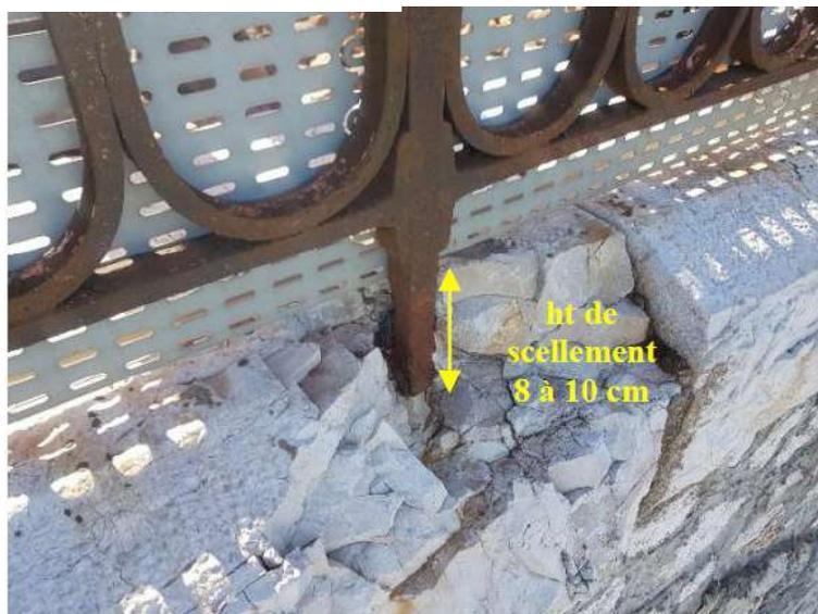
Corrosion montant du garde-corps
