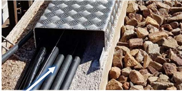
Câbles présents sous la protection métallique, ils devront être déplacés **provisoirement** vers l'extérieur de la longrine BA (positionner en pied de
