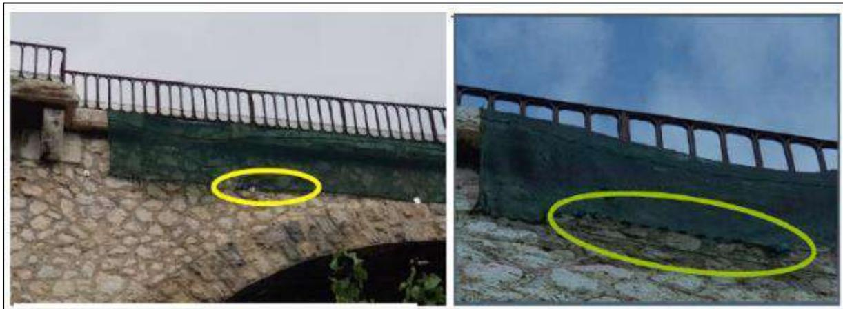
Figure 6 : Exemples de filets de protection fixés au droit du viaduc
