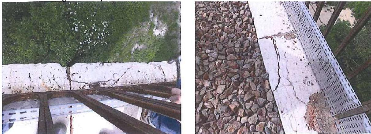
De plus, côté gauche (intérieur de la courbe), une longrine béton armé a été coulée en place sur les pierres de plinthe. Le garde-corps réhaussé a été agrafé sur cette longrine par des épingles en acier. Cette longrine en béton armé n'empêche pas les pierres de se fissurer et de tomber par éléments.
