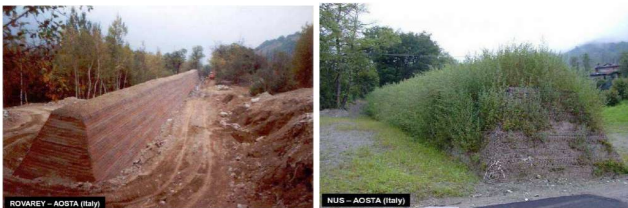
Figure 5 : Exemples de merlons après travaux, à gauche et à long terme, à droite (Source : Maccaferri)
