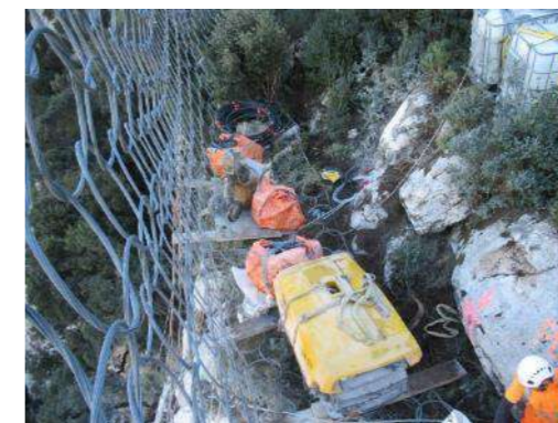
Exemple de mutualisation des emprises temporaires et définitives (ici zone de stockage en falaise dans un filet ASM)
