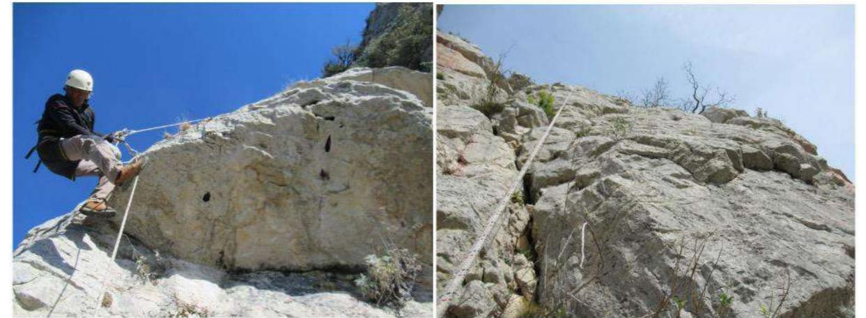
Figure 22 : Illustration de l'utilisation des techniques de cordes dans le cadre de l'inspection en falaise (Photo sur site)
