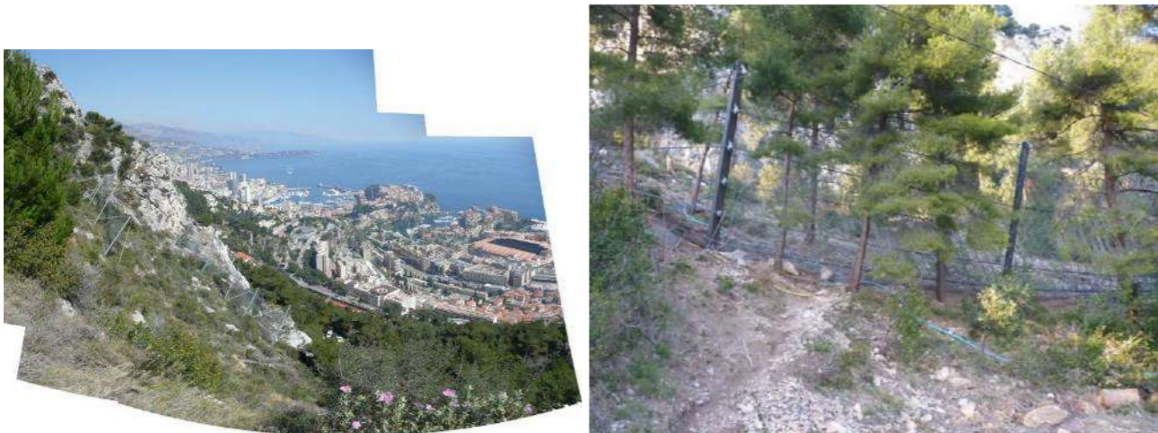
Figure 4 : Exemple d'écrans de filets pare-blocs posés en versant (au-dessus de Monaco) à gauche et d'un écran partiellement masqué par la végétation à droite (Source : GEOLITHE)
