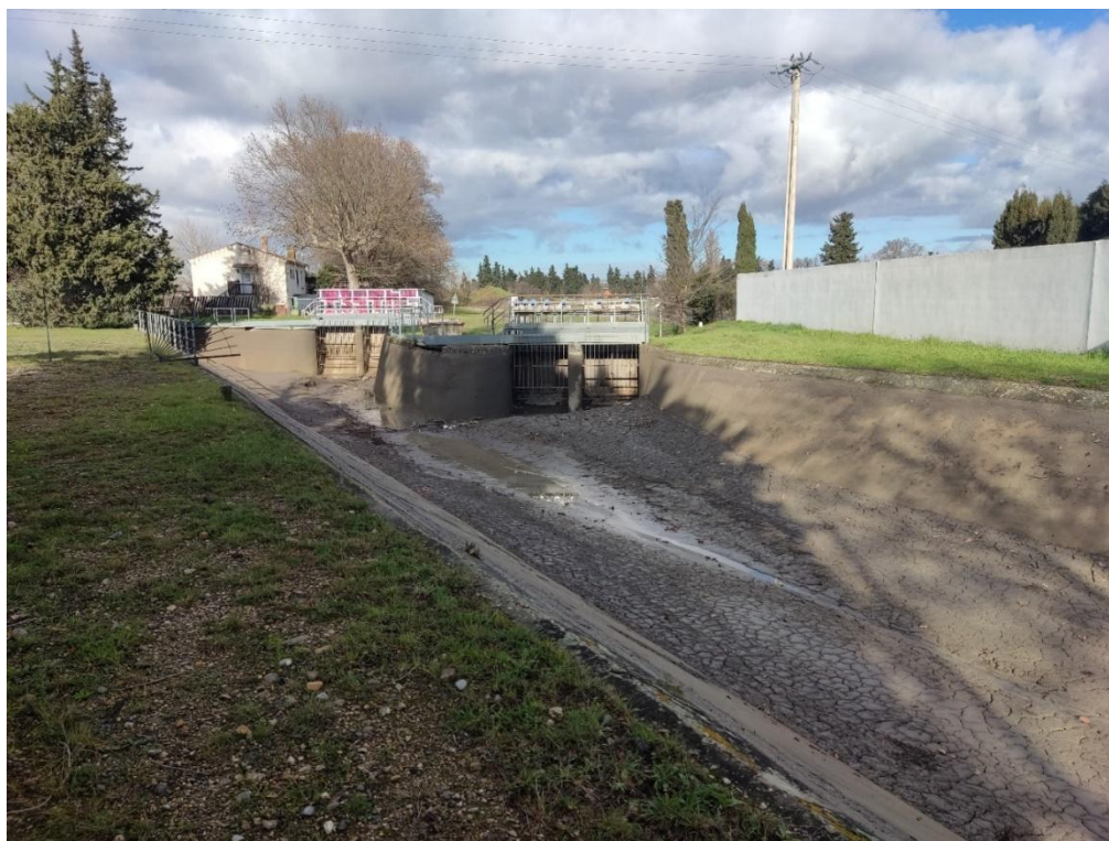
Figure 12 : Prise de vue du point triple au niveau du tronçon n°5
