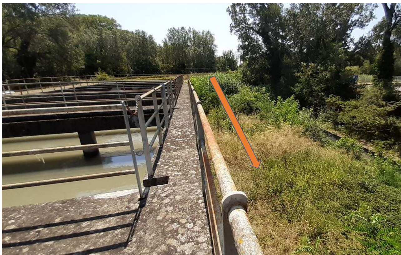
Figure 20 : Accès aux ouvrages du partiteur de Noves
