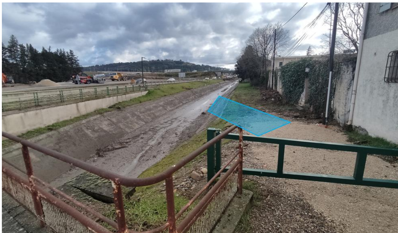
Figure 19 : Prise de vue de la zone d'implantation potentielle de la rampe d'accès « R4 »
