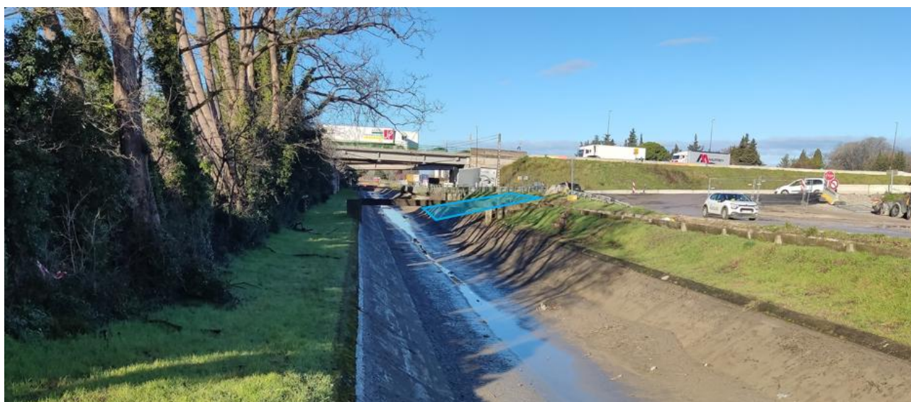
Figure 18 : Prise de vue de la zone d'implantation potentielle de la rampe d'accès « R3 »
