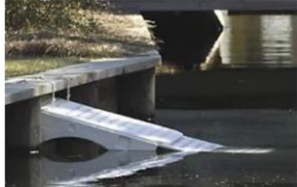
Exemples de rampes échappatoires prévues pour la faune – Images non contractuelles (Source : PSA à gache, Piscine Online à droite) – Nota : la rampe de droite est mal installée puisque les individus de petite taille ne parviendront pas à franchir la marche qui les sépare du quai
