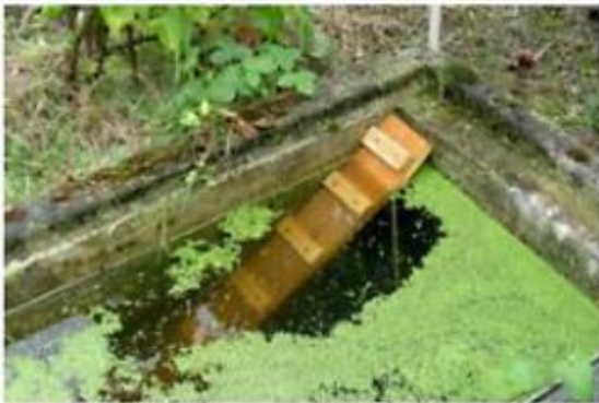
Exemples de rampes échappatoires prévues pour la faune – Images non contractuelles (Source : PSA à gache, Piscine Online à droite) – Nota : la rampe de droite est mal installée puisque les individus de petite taille ne parviendront pas à franchir la marche qui les sépare du quai
