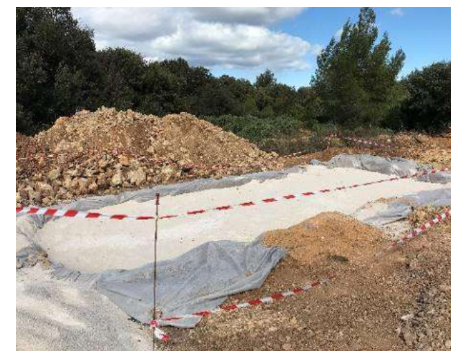
Figure 27 : Fouille préparée pour la pose d'un poste de conversion/transformation (Source : EDF Renouvelables France)
