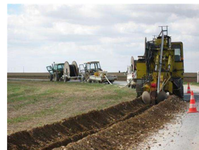
Figure 28 : Réalisation de tranchées du raccordement externe dans l'emprise des voies existantes (Source : EDF Renouvelables France)
