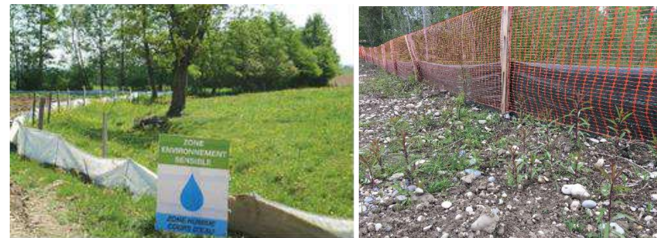
Figure 23 : Signalétique et balisage de milieux naturels (Source : EDF Renouvelables France)
