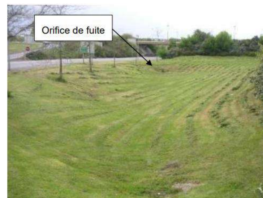
Figure 21 : Exemple d'une noue enherbée (Source: SETEC HYDRATEC)
