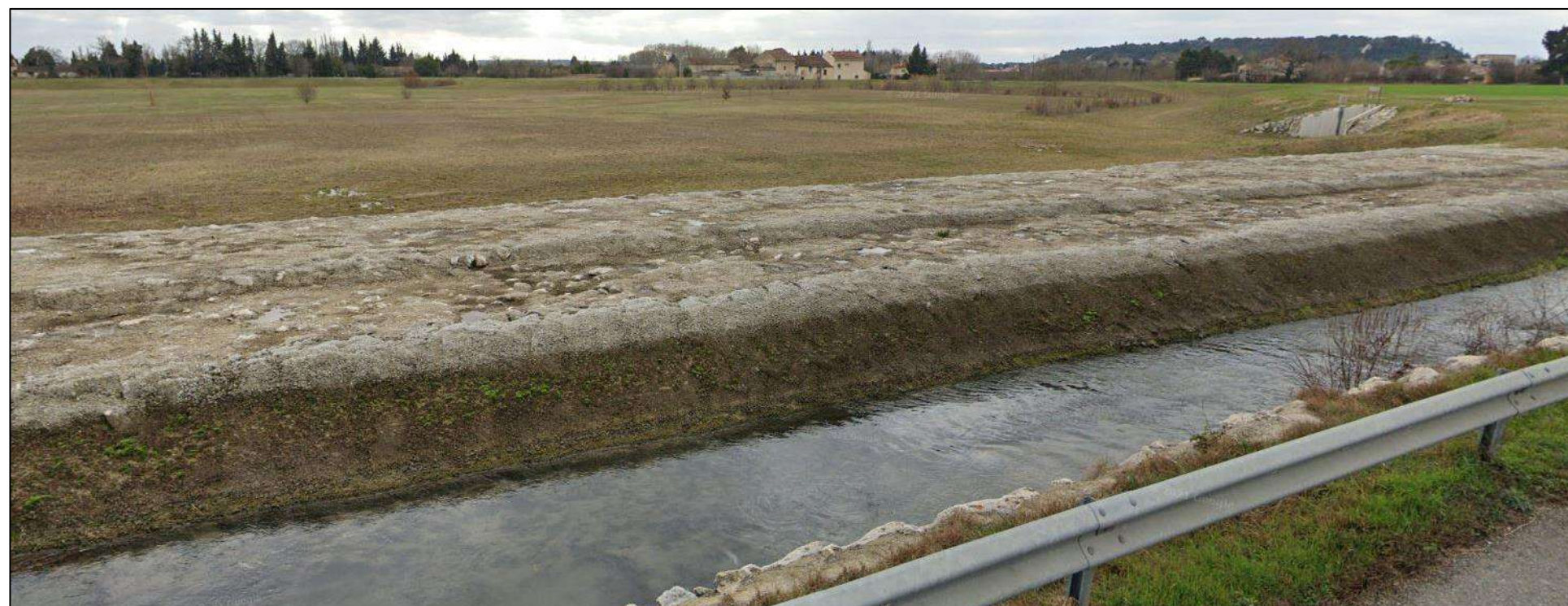
Figure 5 : Bassin de Cagnan-Raphaëlis depuis le nord (RD975) du bassin (source : EDF Renouvelables)
