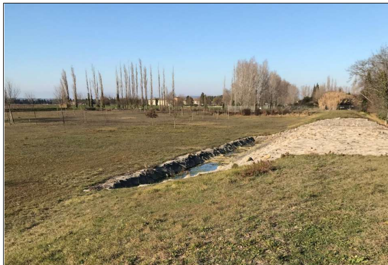
Figure 10 : Bassin du Pont Balençant depuis la digue séparant les deux casiers (Source : ENCIS Environnement)
