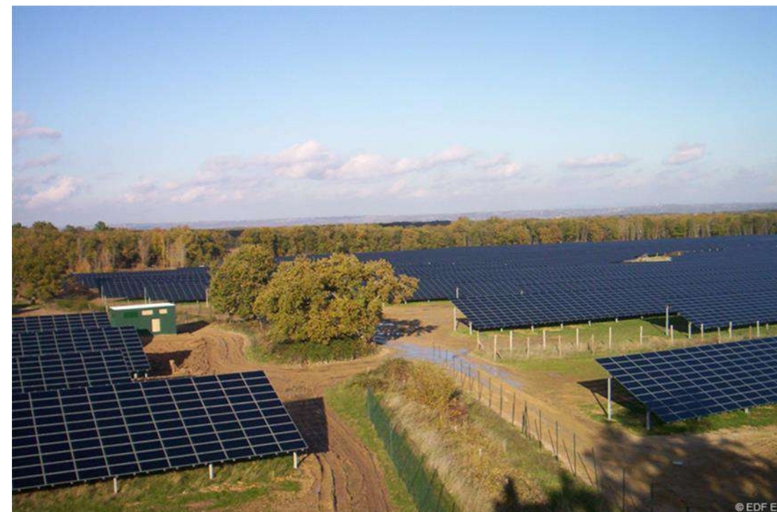
Figure 33 : Fauche différenciée sur la centrale solaire de Narbonne (11) (photo du haut) et corridor écologique préservé en fin de chantier au sein de la centrale de Boulac (31) (photo du bas) Source : EDF Renouvelables France
