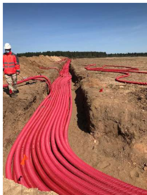
Figure 26 : Exemple de réalisation de tranchées du raccordement interne (Source : EDF Renouvelables France)
