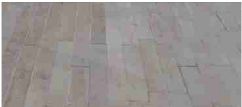
Dalles de pierre calcaire en « bande à courir » alternance de 2 teintes gris-sable claire et foncée largeur 10 cm / longueur comprise entre 30 et 80 cm
