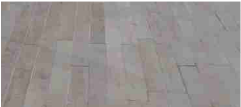
Pierre calcaire bande à courir alternance de 2 teintes gris-sable largeur 10 cm / longueur comprise entre 30 et 80 cm
