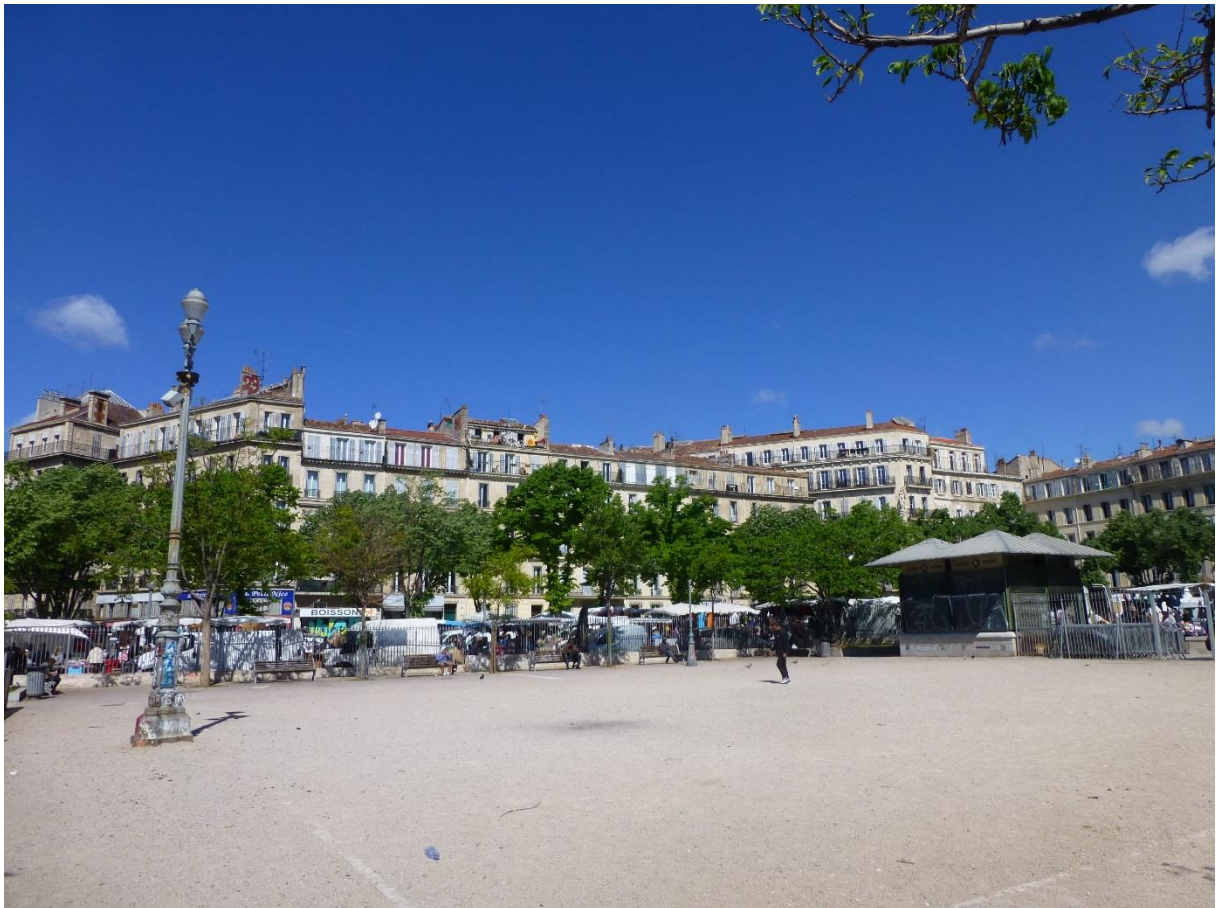
4 – Vue sur le cœur de la place en direction de l'Ouest, avec le marché et un des kiosques existant
