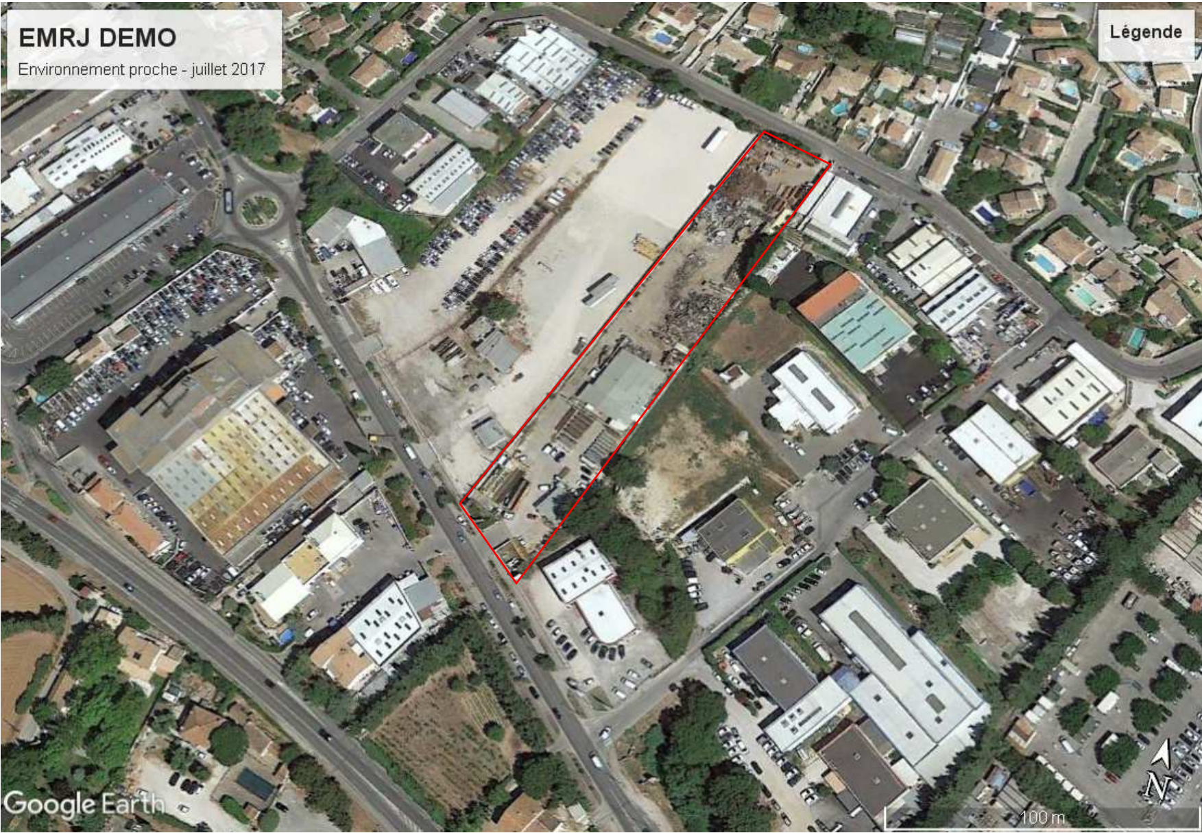
Photo n°1 : Situation dans l'environnement proche
