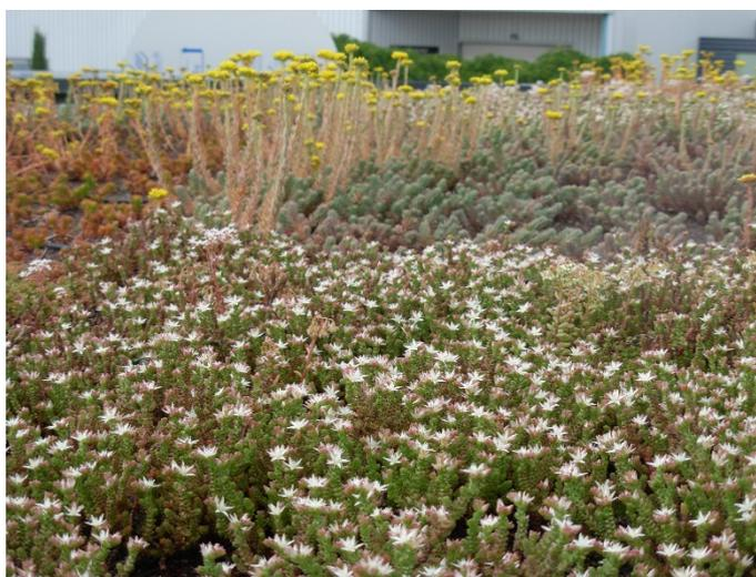
La végétalisation augmente aussi la longévité de la toiture en empêchant les UV de dégrader les matériaux de construction. Les toitures végétalisées augmentent la biodiversité même si les espèces plantées sur les toits sont importées d'ailleurs. Elles filtrent l'air ambiant en éliminant les particules en suspension dans l'air et le dioxyde de carbone (photosynthèse)
