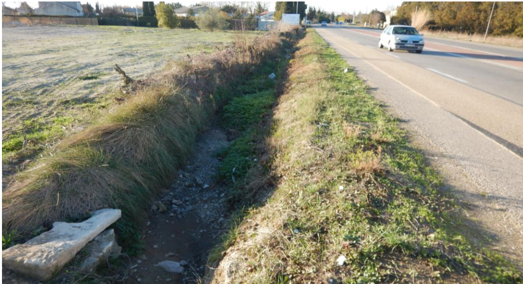
Illustration 4 : Photographie du fossé pluvial au Nord du projet le long de la RD571
