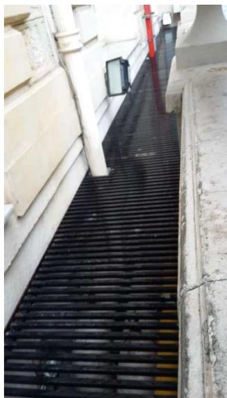
**Photographie 3 : Cour anglaise à travers laquelle les eaux s'infiltrent dans les niveaux inférieurs, côté rue du Canada**
