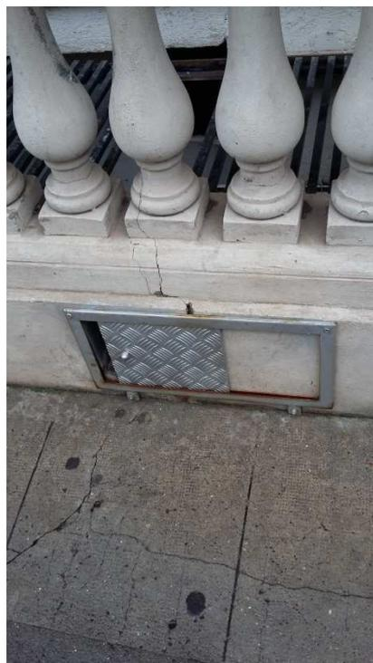
**Photographie 6 : Plaque de protection permettant de limiter les entrées d'eau dans la courette anglaise en cas d'inondation côté rue du Canada**
