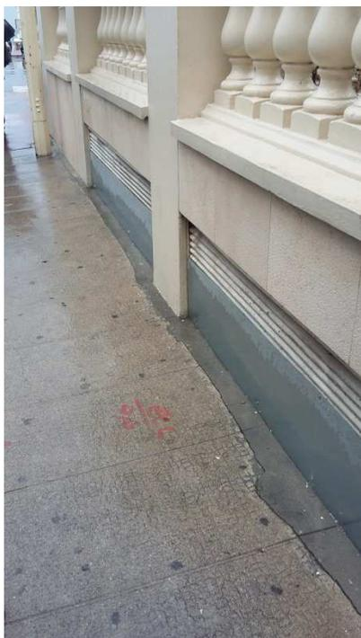
**Photographie 5 : Plaques de protection mises en place pour éviter les entrées d'eau dans les niveaux inférieurs, côté rue du Canada (proche boulevard de la Croisette)**
