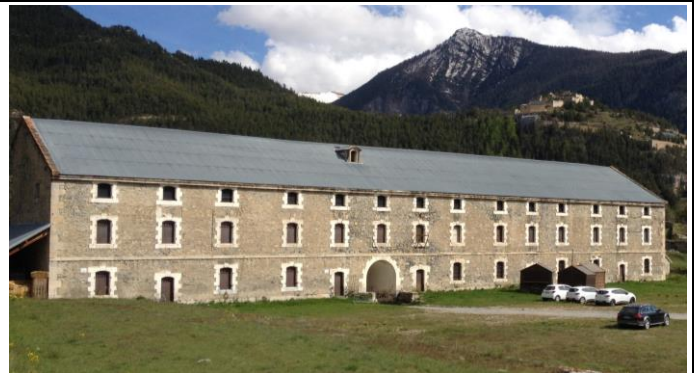
Bâtiment de la caserne – porte Est
