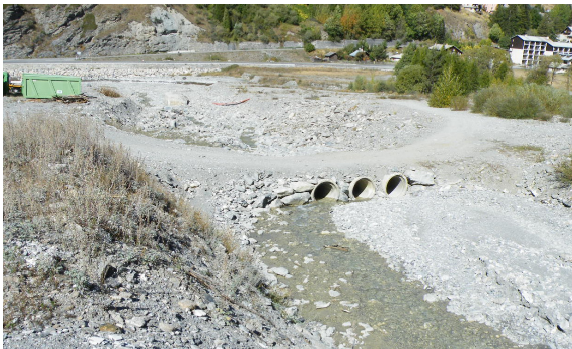
Aperçu du passage busé existant : point haut et obstacle sur le profil en long
