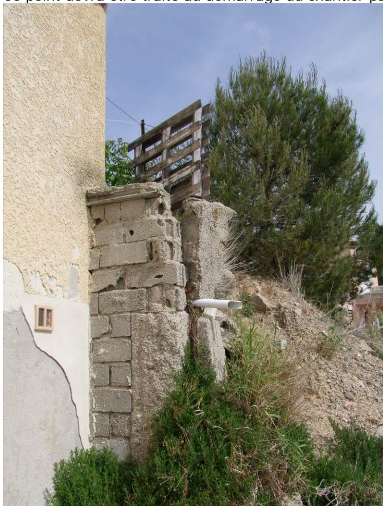
*Mur en état mauvais sous la parcelle DD91 (risque de chute d'élément imminent).*
