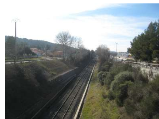
Lignes ferroviaire au droit du Puits Morandat le long de la RD6
