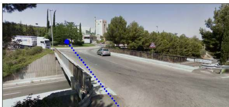
Pont sur la RD6 et giratoire d'accès au site
