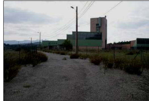
Alimentation électrique du bâtiment du BRGM par le Nord
