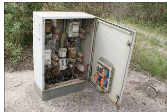
Armoire électrique des mâts de grande hauteur
