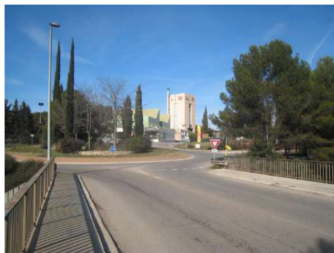
Rond-point à l'entrée du site et pont sur la RD6
