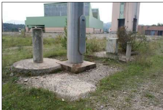
Armoire électrique des mâts de grande hauteur
