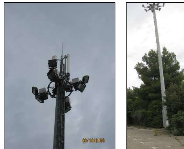
Mâts de grande hauteur
