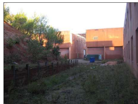
Arrière du bâtiment (partie Nord)
