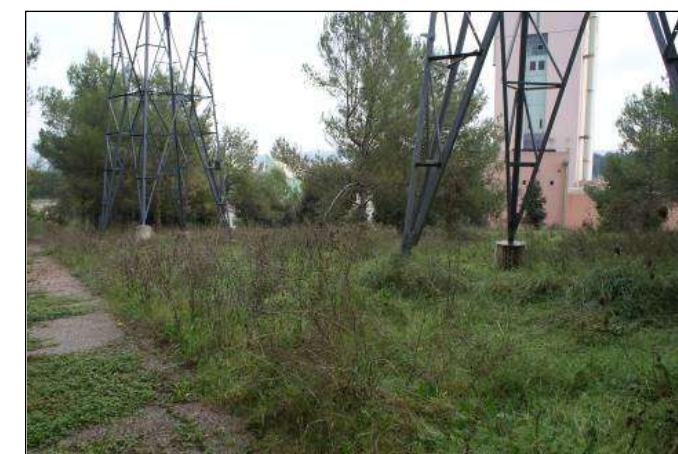
Ancienne alimentation par le réseau RTE
