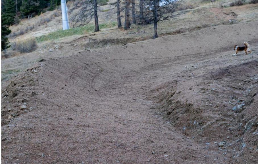
*Figure 11 : Exemple de virage relevé*
