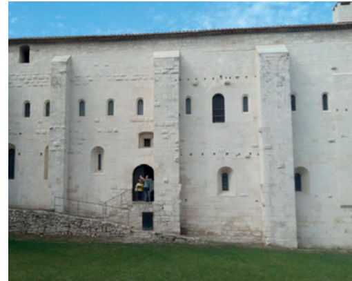
Masse & inertie des murs en pierre
