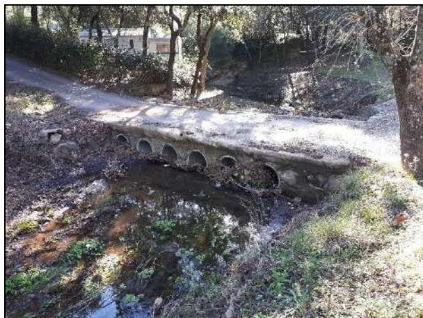
Passage busé générateur d'embâcles ralentissant l'écoulement
