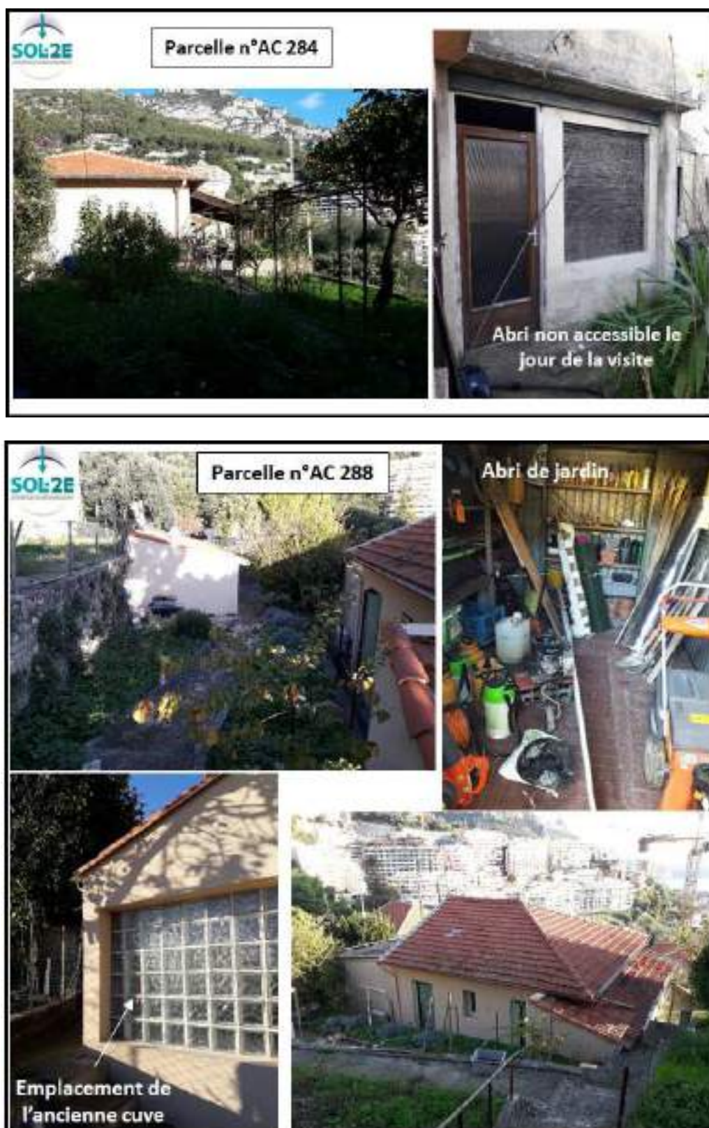
Figure 12 : Photographies de la visite complémentaire du site novembre 2020, parcelles n°AC 280, 283, 284 et 288
