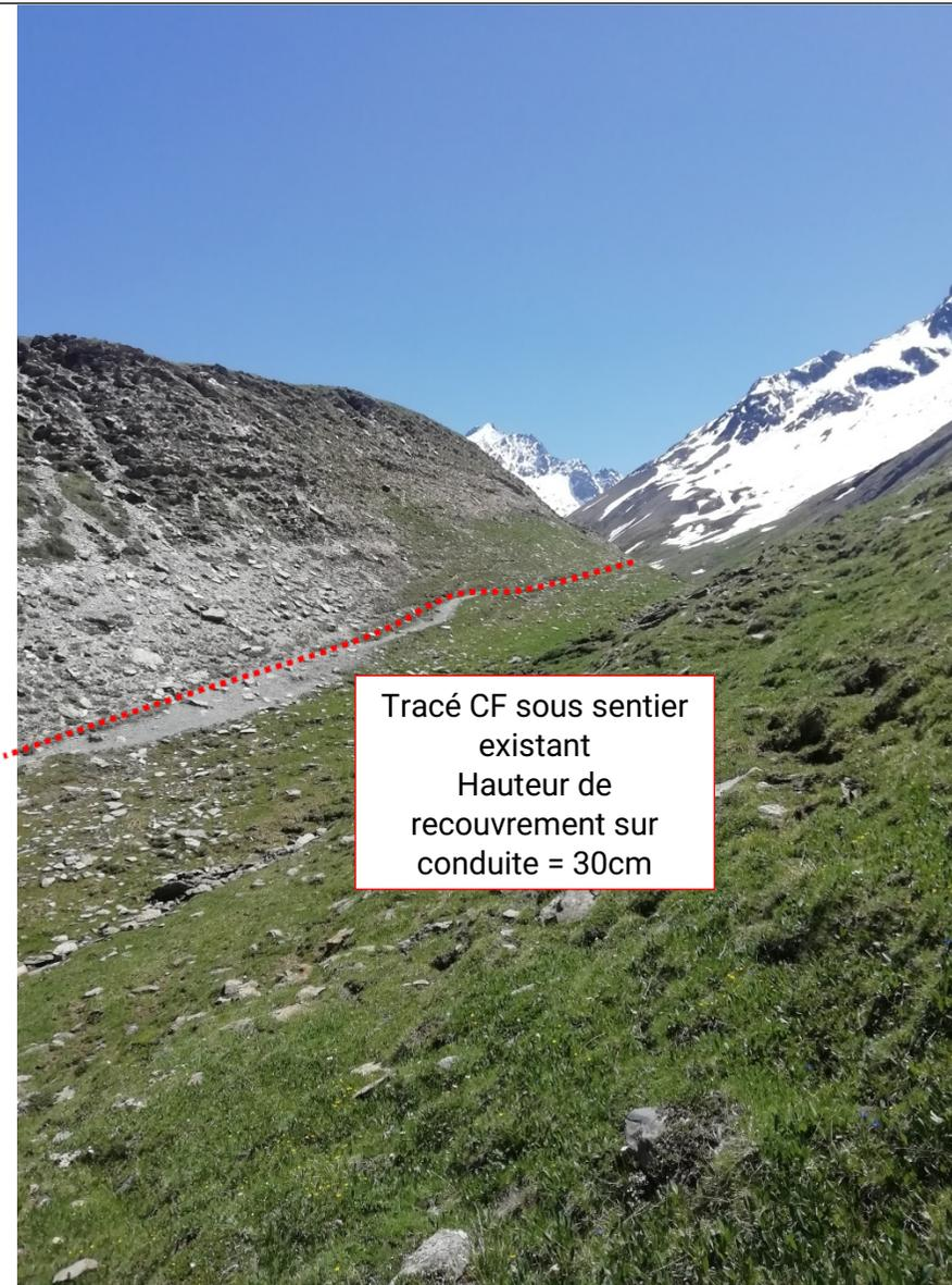
Figure 3 : tracé conduite forcée sous sentier (28/05/2020)
