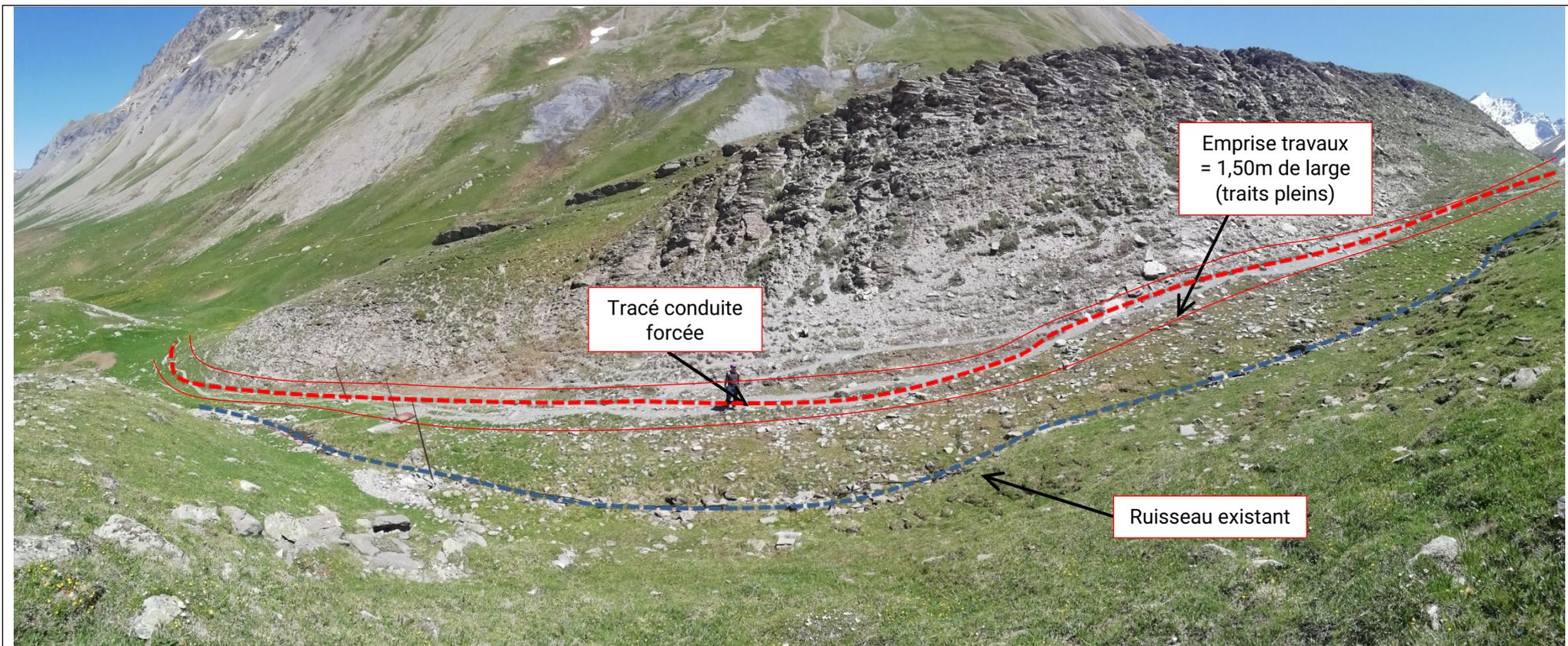
Figure 4 : vue du tracé de la conduite forcée (28/05/2020)
