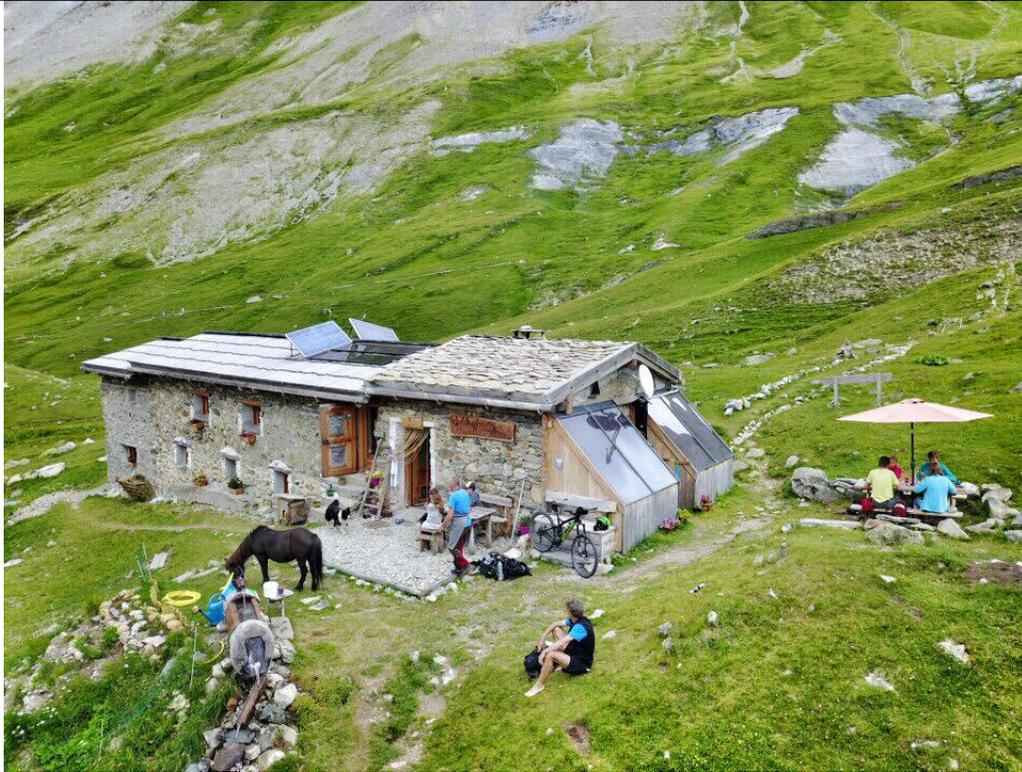
Figure 5 : Le refuge en pierre et lauze pouvant servir de modèle pour bâtiment picocentrale en terme de matériaux et proportion (30/07/2018)
