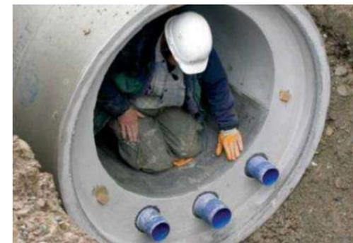
Dans le cas d'un réseau d'assainissement neuf ou lors d'une rénovation de tronçons, les échangeurs de chaleur peuvent être intégrés à la canalisation. Dans le cas inverse, les systèmes sont réalisés au cas par cas et déposés au fond des canalisations. Cependant, la mise en place de ce système, qui est aisée pour des constructions nouvelles, sera difficile et chère pour des canalisations anciennes et de petits diamètres.
