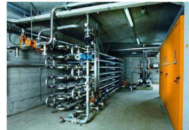
Figure 18 : Echangeur tubulaire en sortie de STEP (Lyonnaise des Eaux, ISTINOX, ANTEA)
