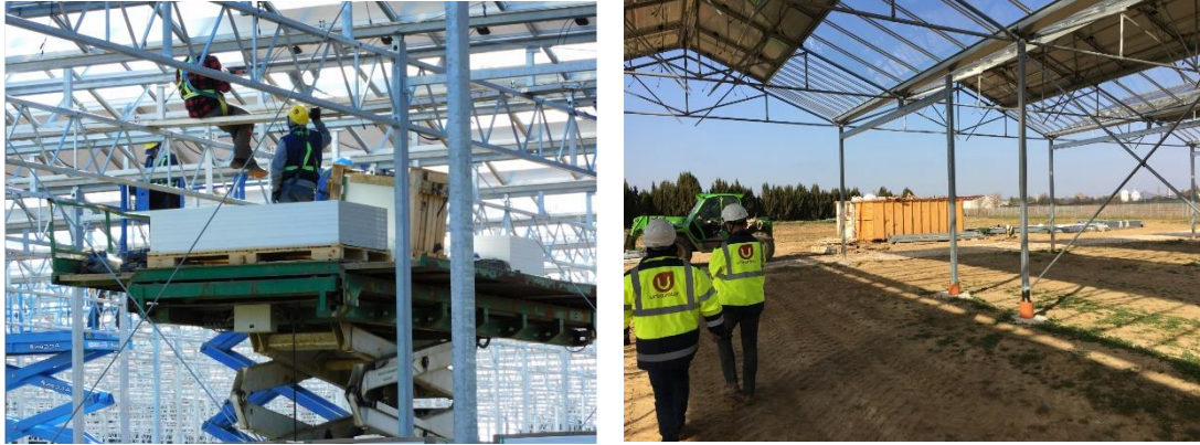
Figure 19. Photographies du montage des structures
