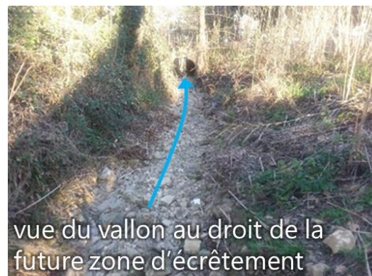
vue de la future zone d'écrêtement
