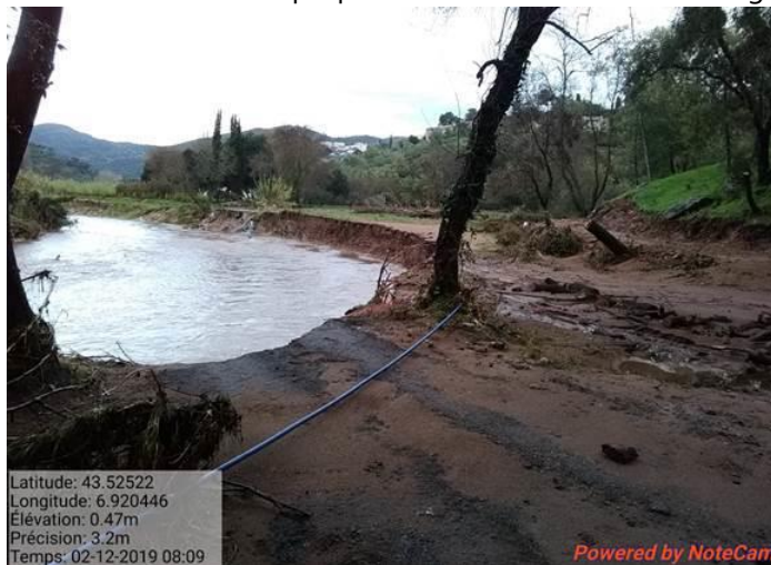
Figure 2 : photographie des dégâts causés par les inondations de 2019- Site des Grafontaines
