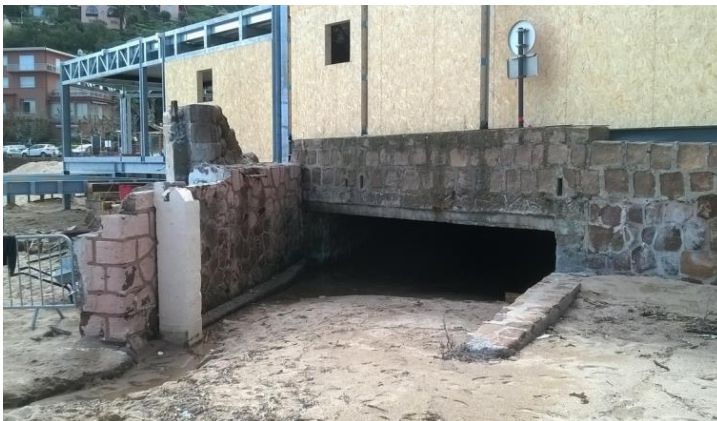
vallon de l'Autel à l'exutoire
