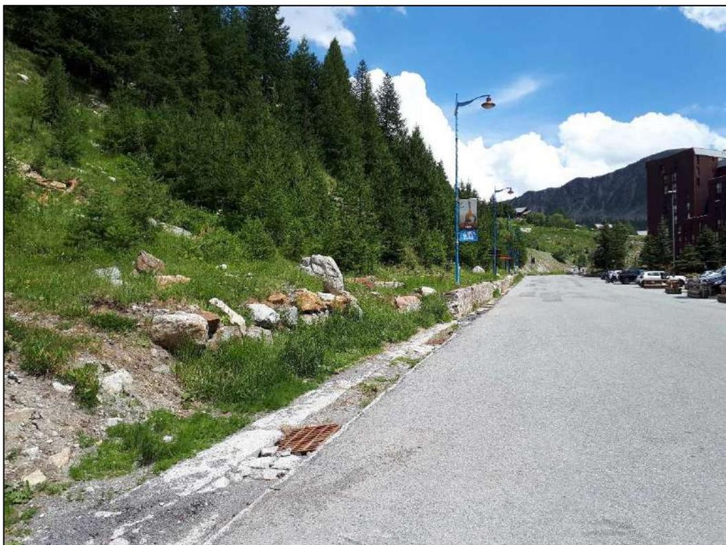
*Photographie 3 : Le réseau pluvial existant en bordure de la route du Front de Neige*
