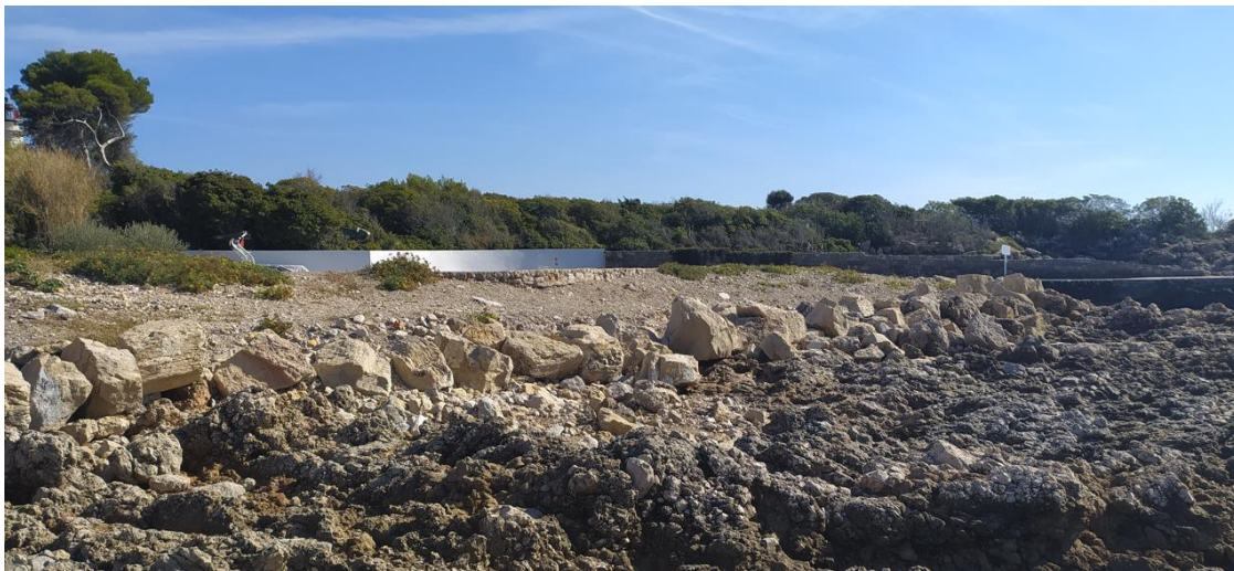
Figure 20 : Protection en enrochement le long du mur abri – ICTP 10/2022
