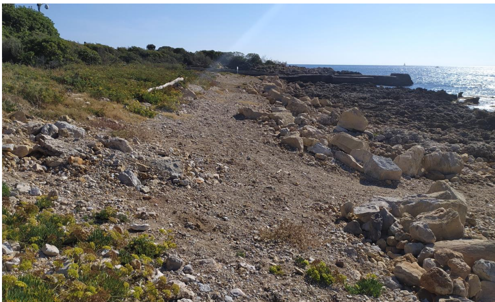
Figure 21 : Protection en enrochements le long du littoral – ICTP 10/2022
