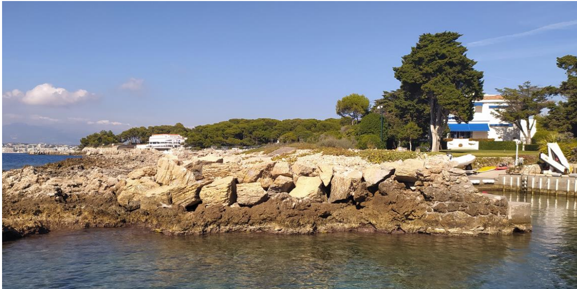
Figure 19 : Protection en enrochement à l'angle du port abri – ICTP 10/2022
