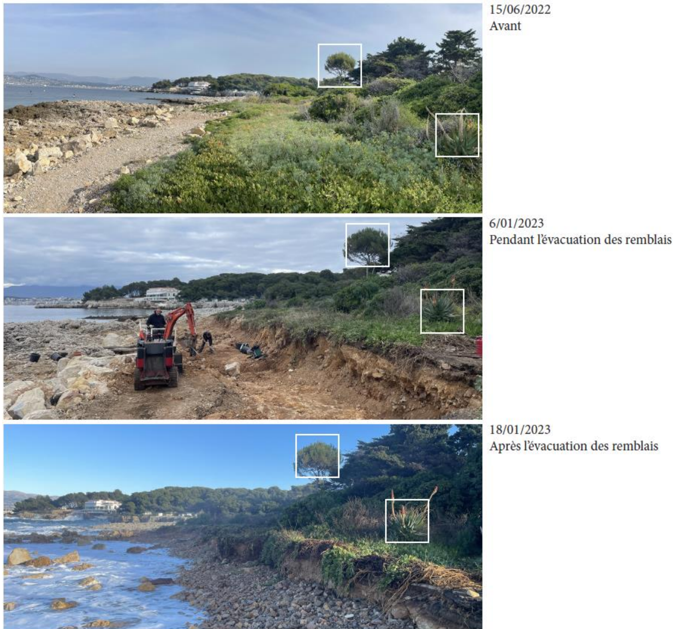
Figure 31 : Perte de talus végétalisé lors du coup de mer du 17/18 janvier 2023 – Atelier Sacha GIGANT janvier 2023
