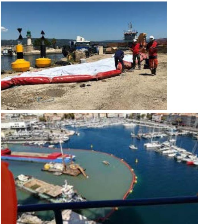
FIGURE 16 : EXEMPLE DE DISPOSITIF DE BARRAGE ANTI-MES DÉPLOYÉ DANS LE CADRE DE TRAVAUX DANS LE PORT DE LA CIOTAT (SOURCE EGIS 2021)
