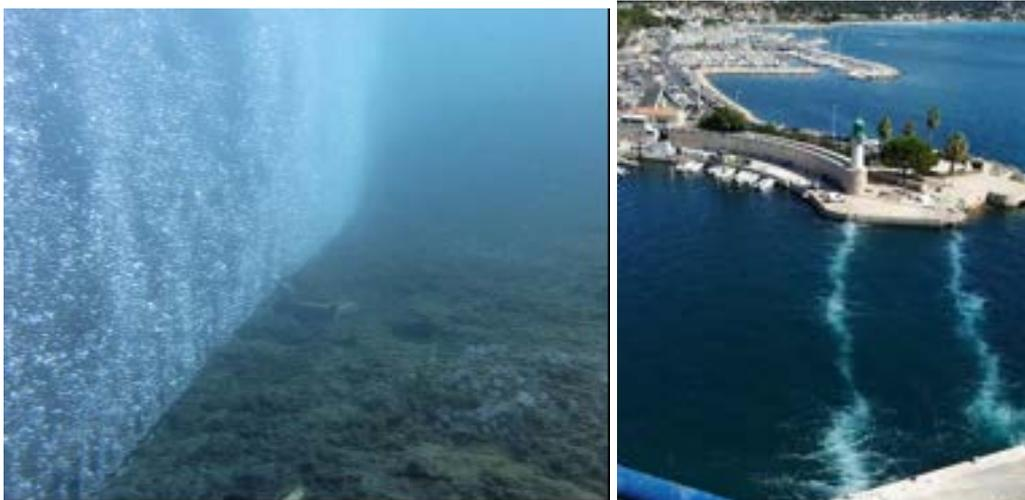
FIGURE 17 : EXEMPLE DE RIDEAU À BULLES DÉPLOYÉ DANS LE CADRE DE TRAVAUX DANS LE PORT DE LA CIOTAT (SOURCE EGIS 2021)
