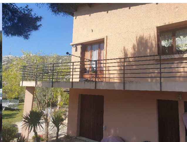
Point 3 (vue vers maison)
