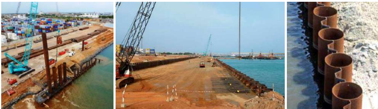
Figure 31 : Réalisation du rideau mixte (Quai conteneur de Lomé, 2012)
