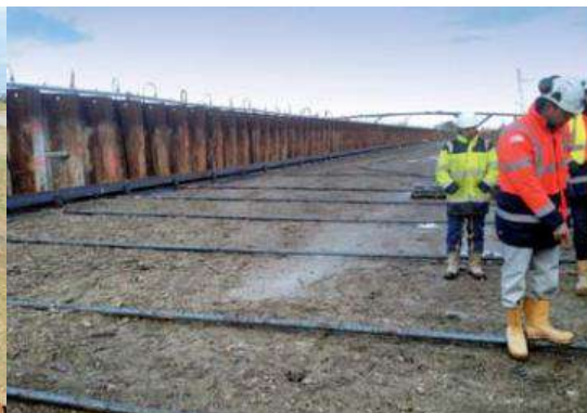
Figure 30 : Mise en place des tirants et des liernes
