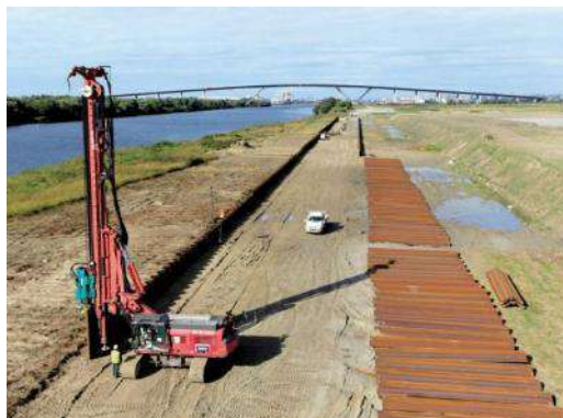
Figure 29 : Battage des palplanches
