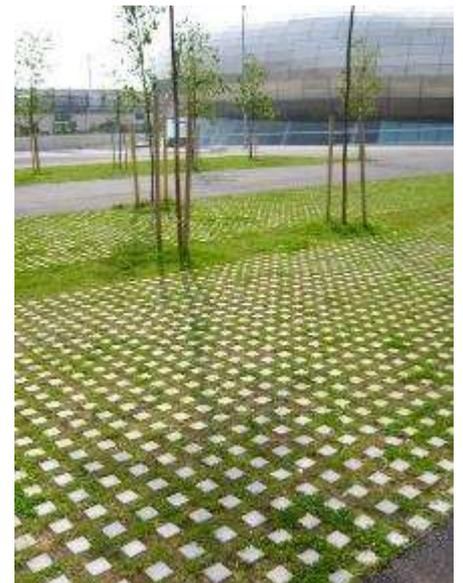
La pollution du parc de stationnement des véhicules sera traitée par le procédé phyto-sanitaire généré par le dépôt des MES au passage du ruissellement sur les emplacements perméables engazonnés.
