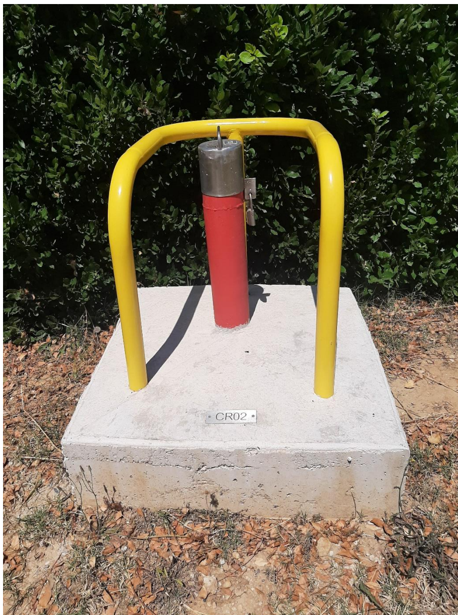
Figure 2 : Extension de l'ouvrage une fois terminé
