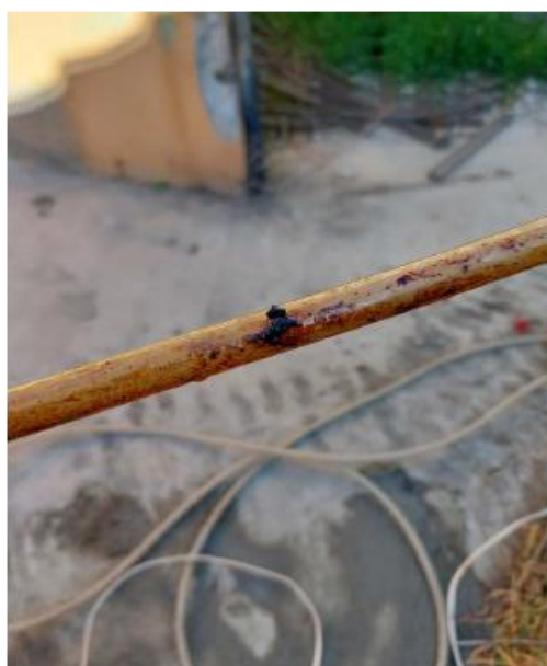
Figure 31 : Gouttelettes d'hydrocarbures relevées au droit de Pz7 le 8 février 2023
