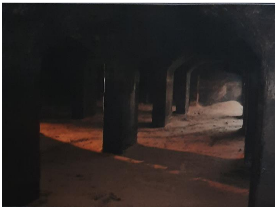
Figure 16 : Vue des piliers et des structures de la cuve C1-CA après vidange (Source : rapport EAT)
