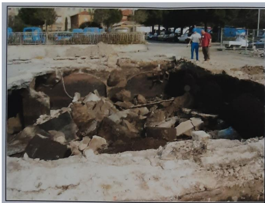
Figure 15 : Démolition du toit et des piliers de la cuve C1-A après vidange et nettoyage (Source : rapport EAT)
