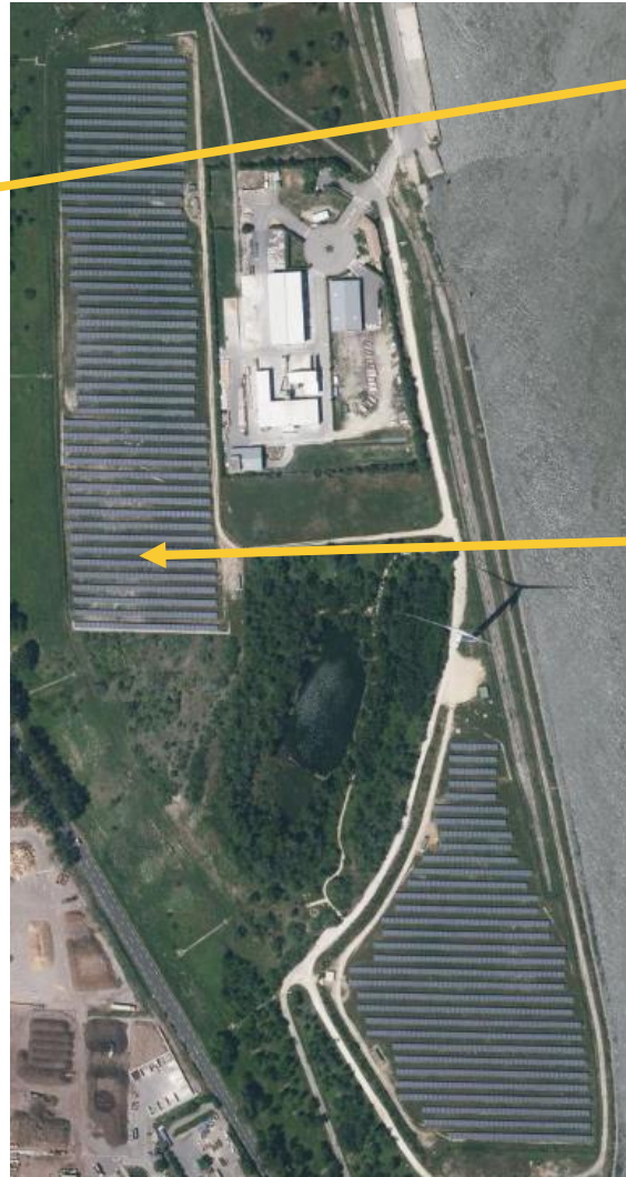
Centrale PV de Bollène 1
