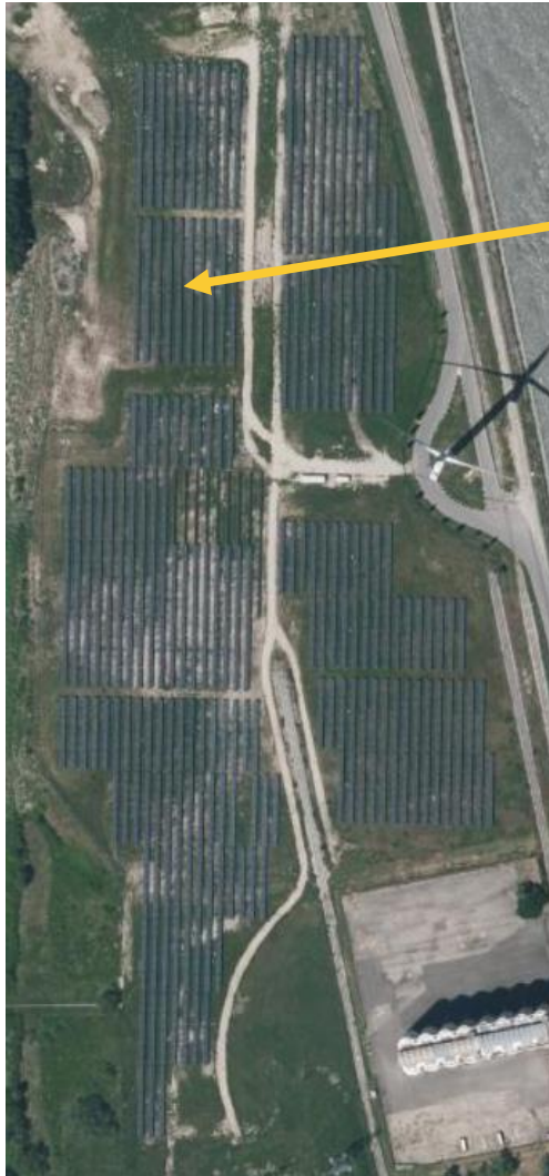
Centrale PV de Bollène 2
