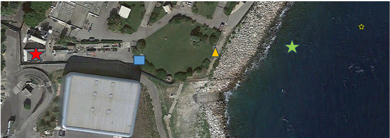
Figure 38 : Implantation du dispositif de protection cathodique de l'émissaire de la Californie et l'intercepteur EST
