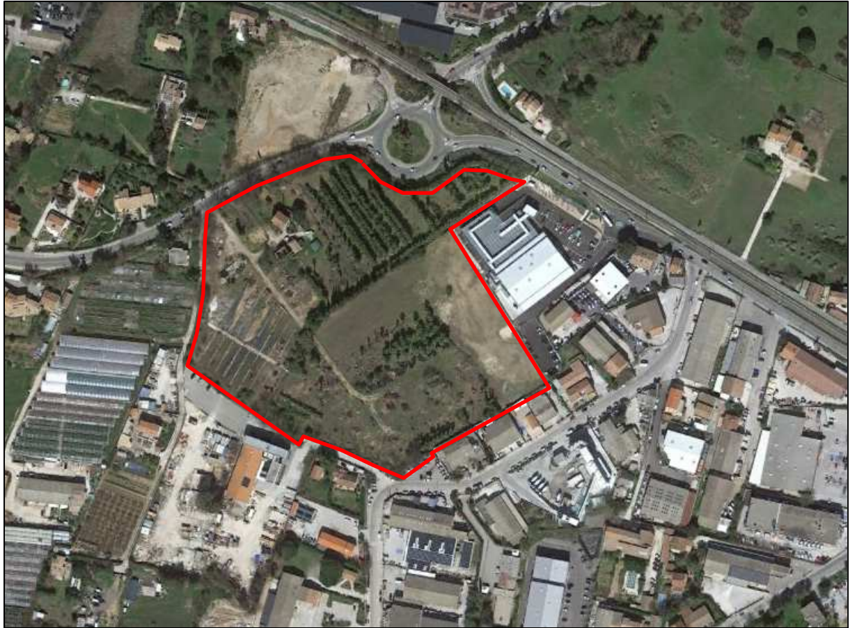
Vue satellite du terrain du projet
